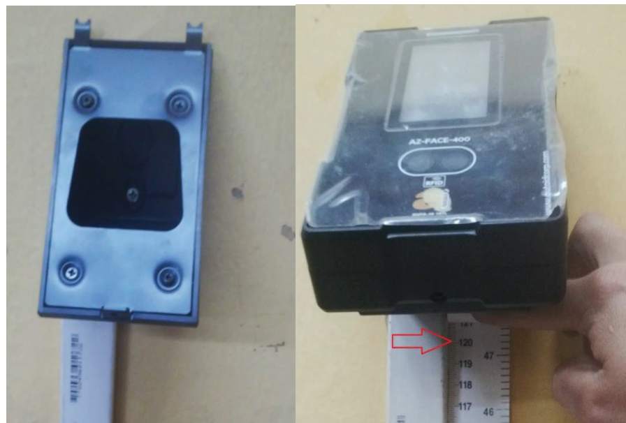
Figura 31 Empotrado de plantilla del biométrico
