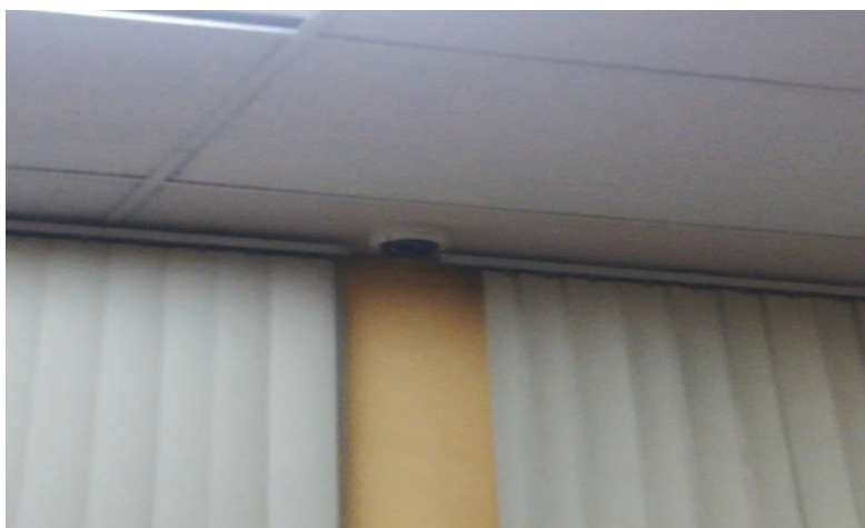
Figura 23 Ubicación física de la cámara 02
