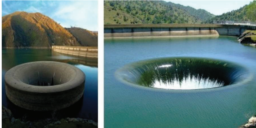
Fotografía 4. Torres de toma agua. (Fuente: Álvarez, 2015)
