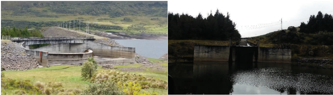
Fotografía D9. Vertedero y zona de descarga para niveles máximos de cota
