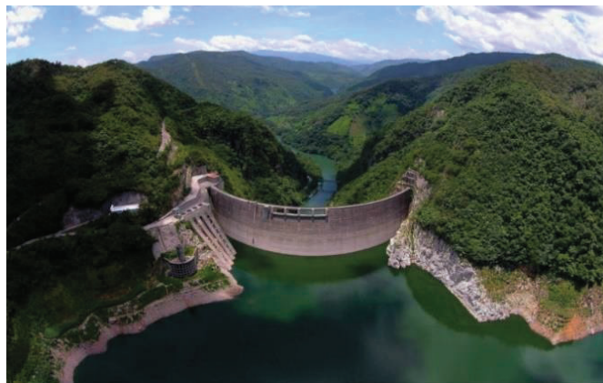
Fotografía 3. Tomas de agua en el flanco derecho de un embalse. (Fuente: Álvarez, 2015)
