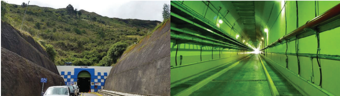
Fotografía D2. Ingreso a casa de máquinas Central Hidroeléctrica Pucará
