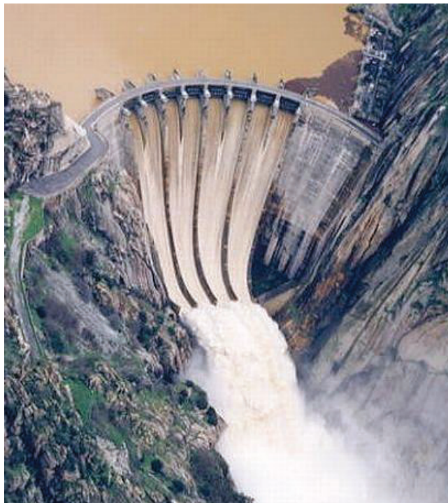
Fotografía 1. Represa de hormigón armado para acumulación de agua en Aldeadávila (España). (Fuente: Aldeadávila - Iberdrola, 1995e)
