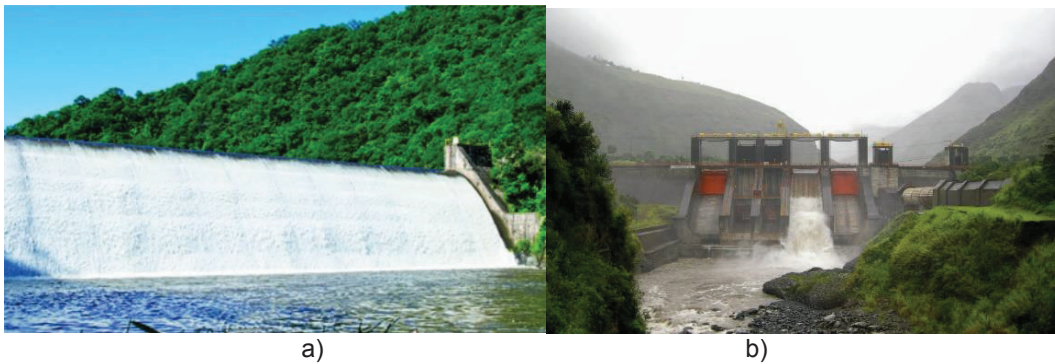
Fotografía 6. Ejemplo de tipos de vertedero a) libre b) de compuertas (represa Agoyán). (Fuente: a) Álvarez, 2015 y b) CELEC EP Hidroagoyan, 1995)
