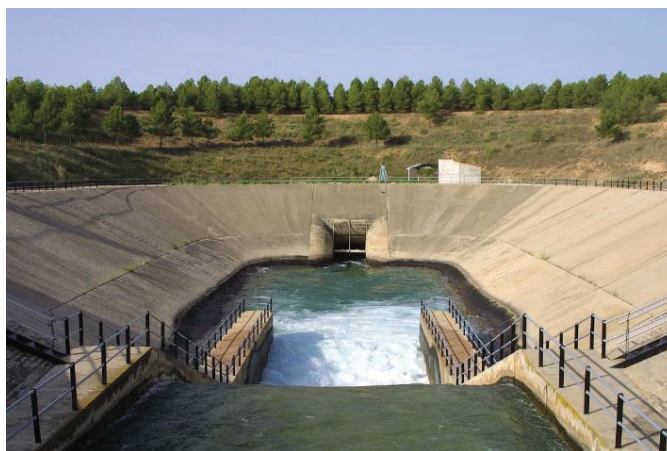
Fotografía 8. Captación de agua a la cámara de carga del complejo Tajo – Segura (España). (Fuente: Centro de estudios hidrográficos, 1998a)
