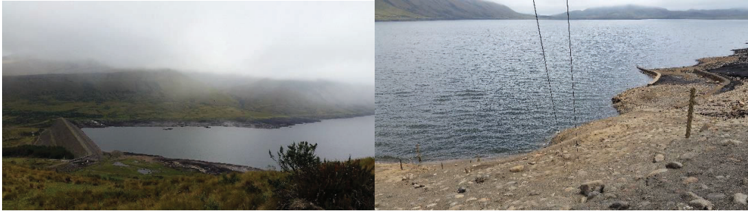
Fotografía D8. Dique laguna Pisayambo y zona de aducción para inicio túnel de conducción
