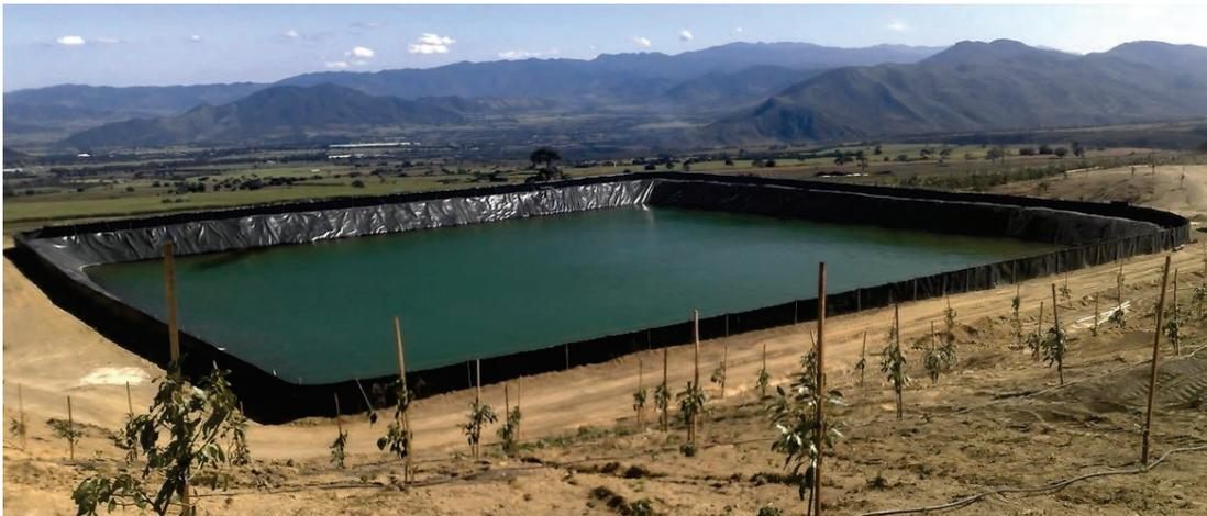
FIGURA 7-1. RESERVORIO DE AGUA CUBIERTO CON GEOMEMBRANA
