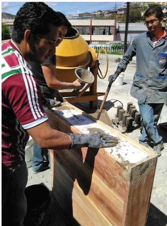
**GRÁFICO 0.8:** Proceso de fundición de muretes de M.R.A.
