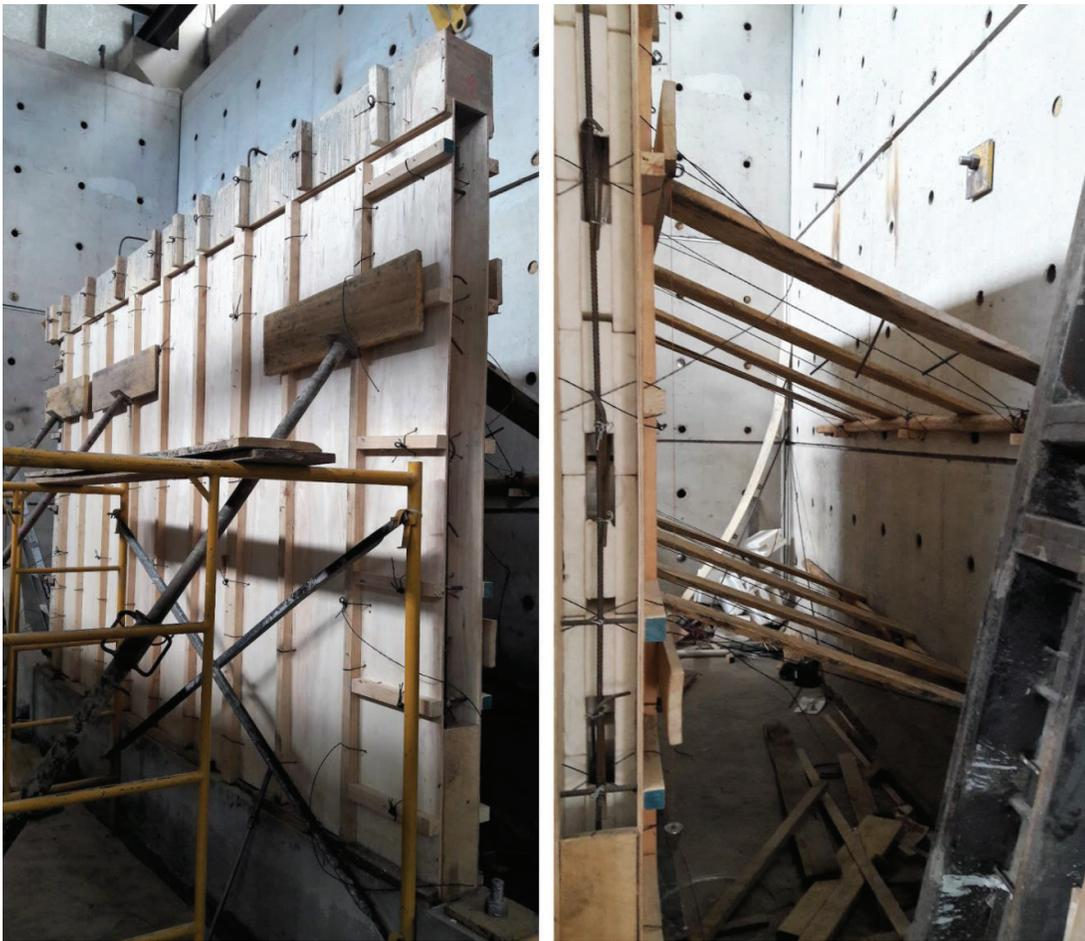
**GRÁFICO 0.19:** Encofrado y apuntalado del muro.
