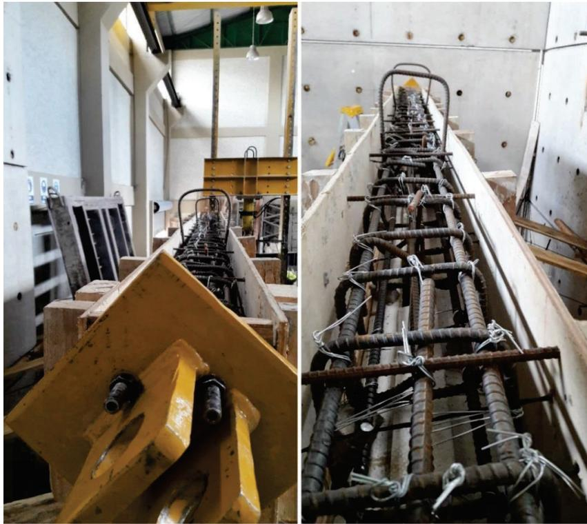
**GRÁFICO 0.20:** Viga de carga del muro de M.R.A. **Fuente:** JP. Herrera y J. Narváez.
