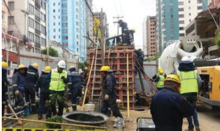
Figura 29. Trabajos de excavación y cimentación para pílona, Bolivia. Fuente: (MiTeleférico, 2015)
