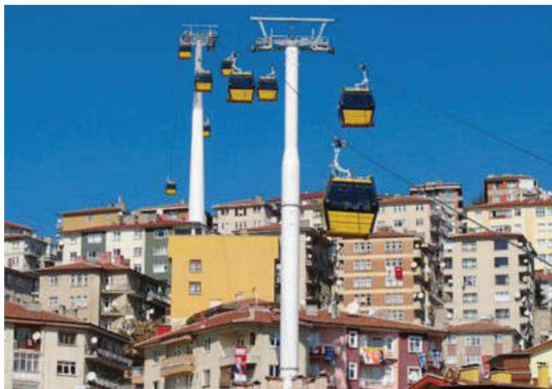
Figura 27. Torres cilíndricas del sistema Yenimahalle, Turquía. Fuente: (Leitner, 2014)
