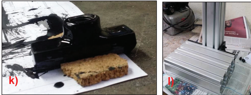
Figura 2.62. k) Proceso de recubrimiento a los apoyos y dados, l) Perfiles base y perfil columna ensamblados. (Fuente: Propia)
