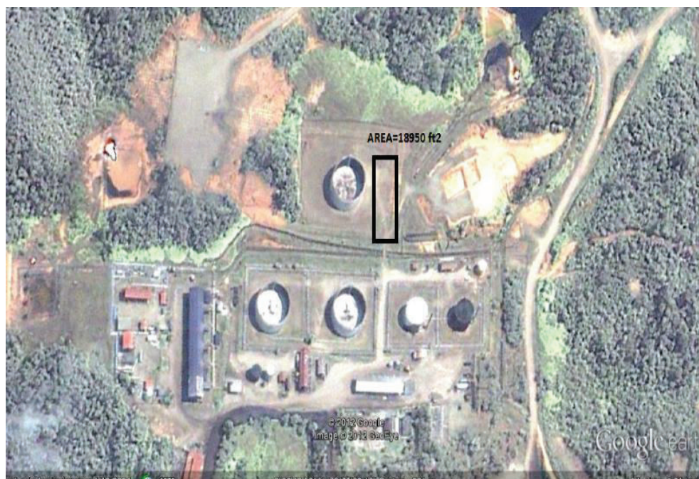
FIGURA 2-2: UBICACIÓN GEOGRÁFICA DE LA ESTACIÓN SECOYA (Pardaliservices, 2012)
