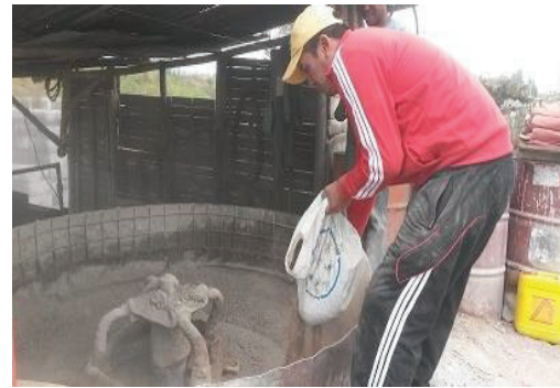
Se añade el lodo pulverizado
