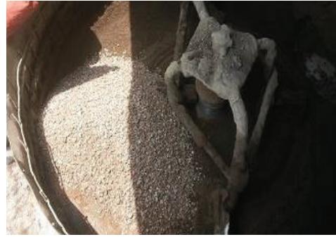
Colación del material en la mezcladora
