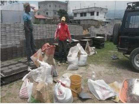
Acopio de material con las dosificaciones
