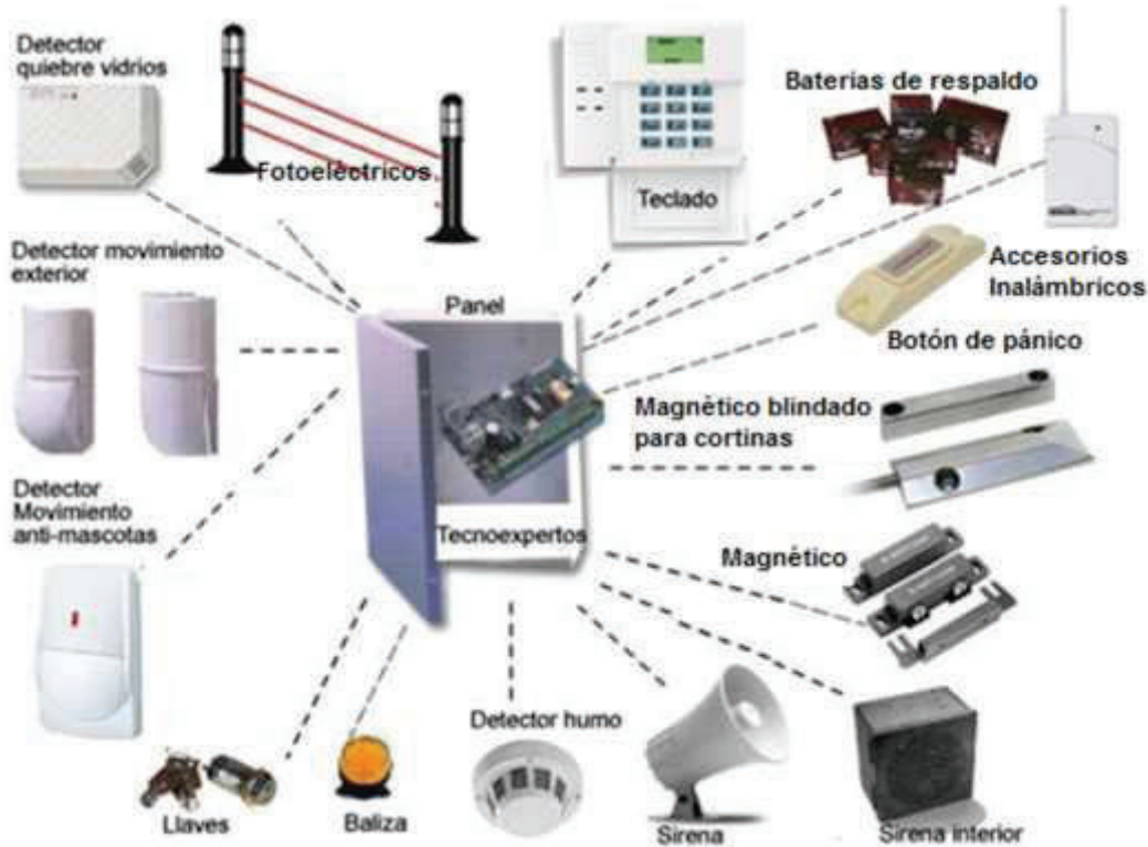
Figura 1.1 Estructura de un sistema de seguridad [1]
