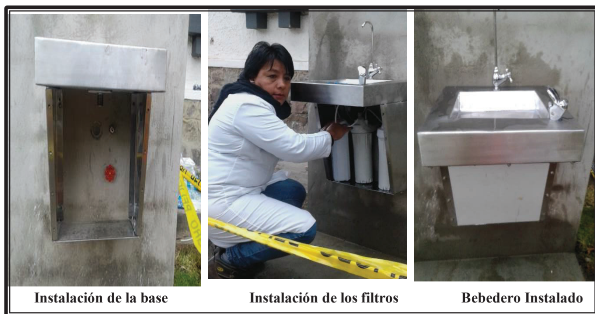
Figura 20. Instalación del bebedero
