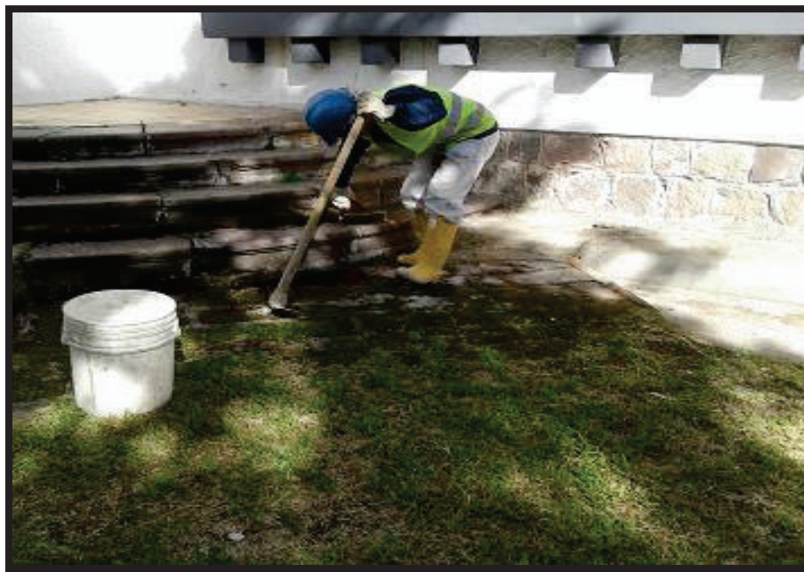
Figura 13. Remoción de la capa vegetal. Instalación de tubería de suministro al bebedero
