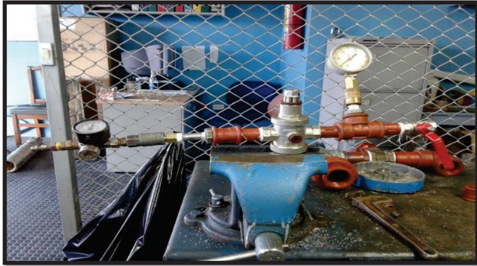
Figura 16. Calibración de la válvula de reducción de presión
