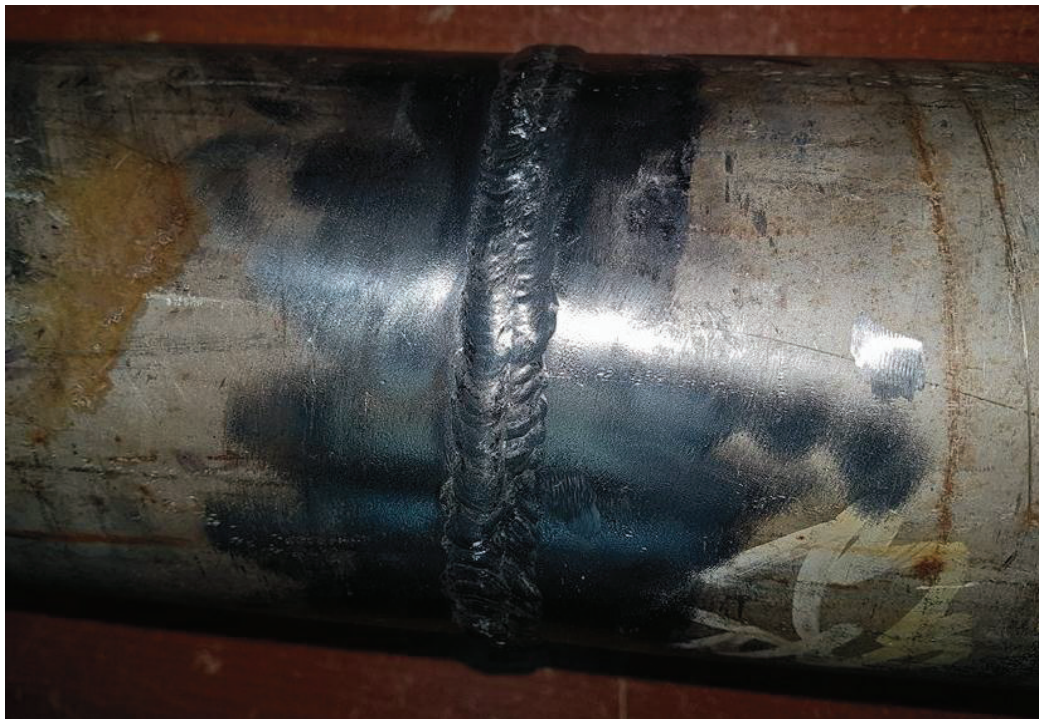
Figura 2.2. Probeta para ensayo de tintas penetrantes. Fuente: Propia
