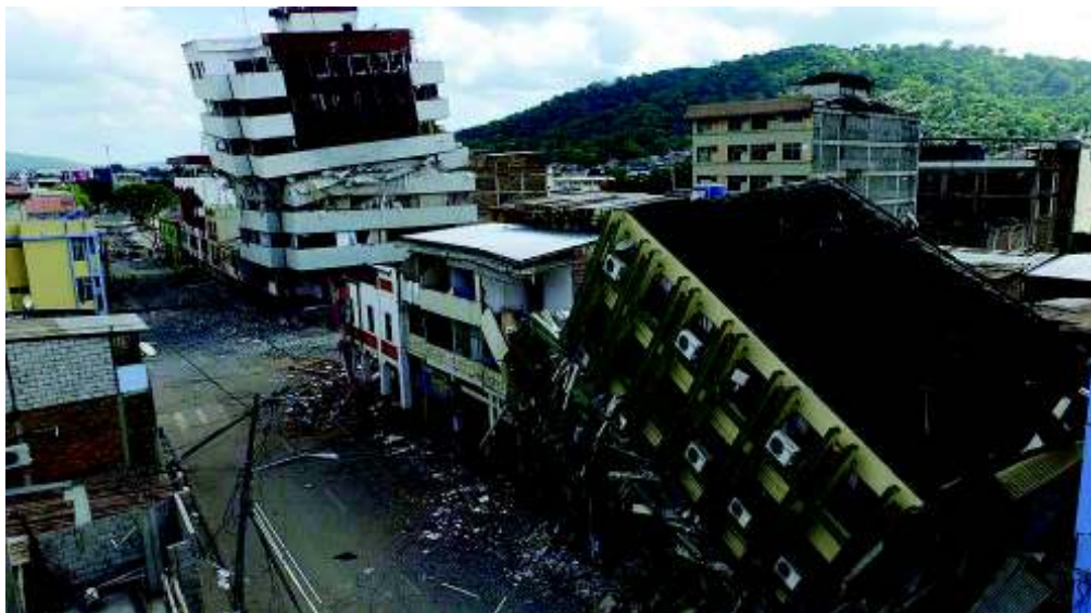
FIGURA 1.3 DAÑOS EN ALGUNAS ESTRUCTURAS DEBIDO AL SISMO DEL 16 DE ABRIL.
