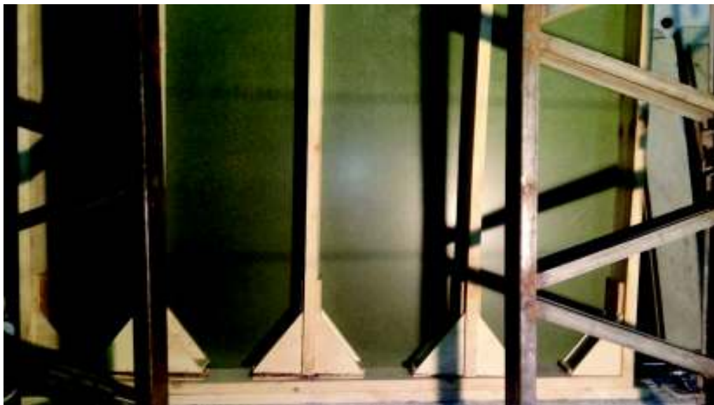
FOTOGRAFÍA 5.6 DAÑOS EN MURO MPE 1X8-12 ALCANZADA LA CARGA MÁXIMA.
