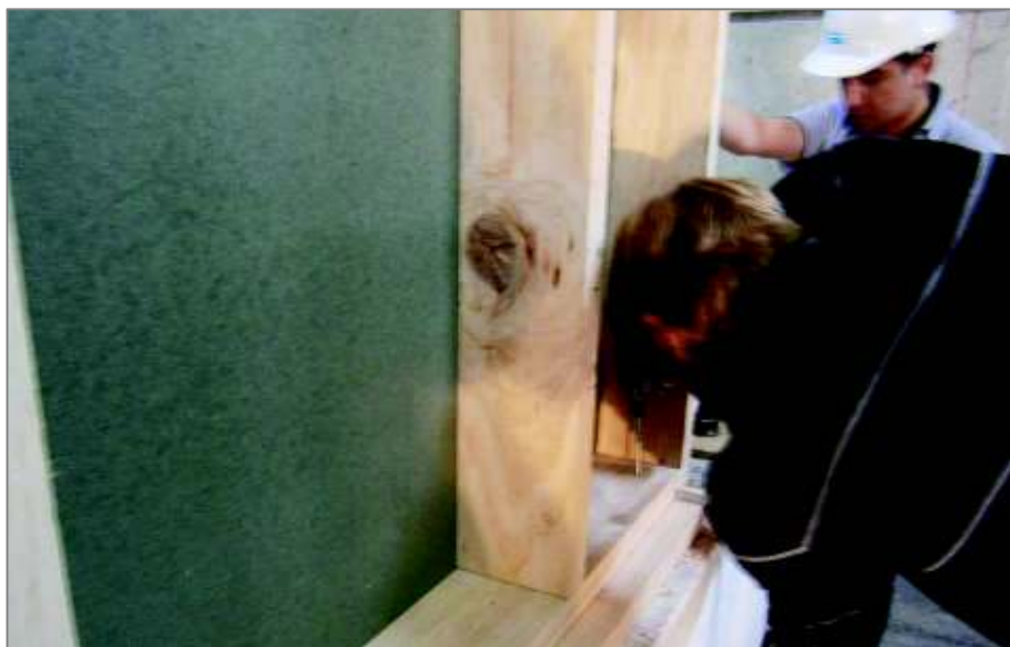
FOTOGRAFÍA 4.25 UNIÓN DEL MURO A LA SOLERA BASE.
