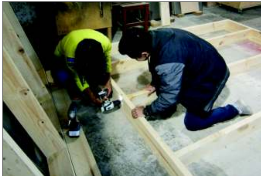
FOTOGRAFÍA 4.19 ENSAMBLE DEL BASTIDOR (B)
