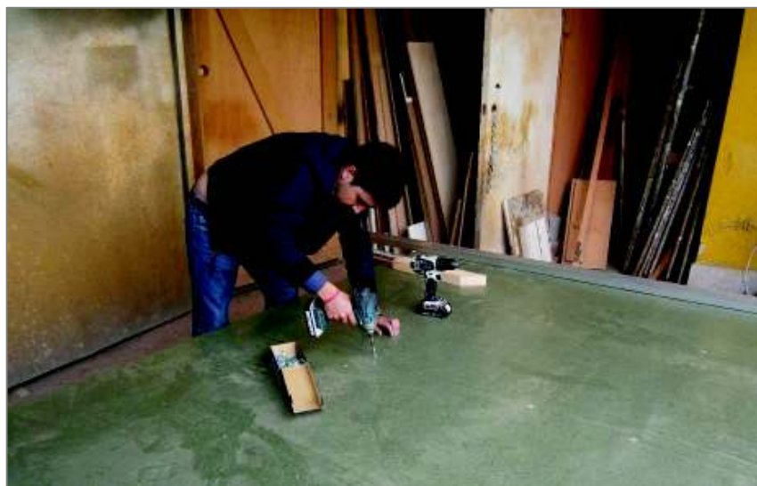
FOTOGRAFÍA 4.21 UNIÓN DE LA PLACA RIGIDIZANTE AL BASTIDOR (B)
