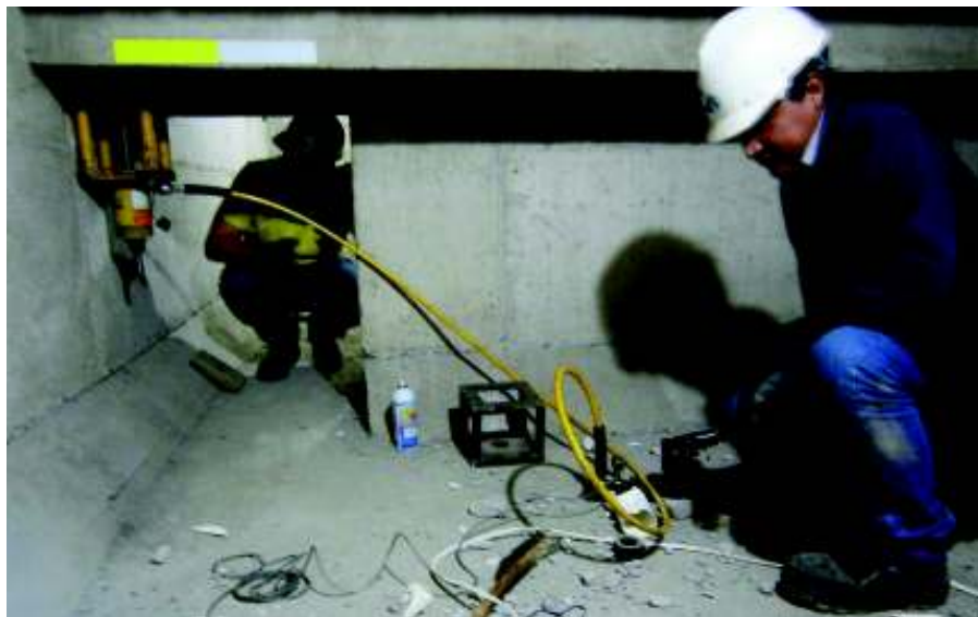
FOTOGRAFÍA 4.26 APLICACIÓN DE TENSIÓN DE PRE-ESFUERZO EN EJES.
