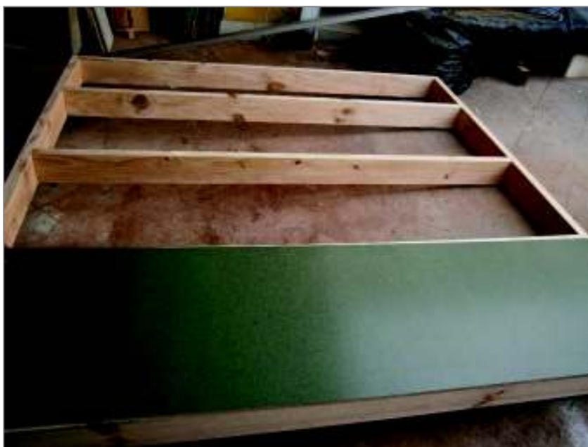
FOTOGRAFÍA 4.21 UNIÓN DE LA PLACA RIGIDIZANTE AL BASTIDOR (B)
