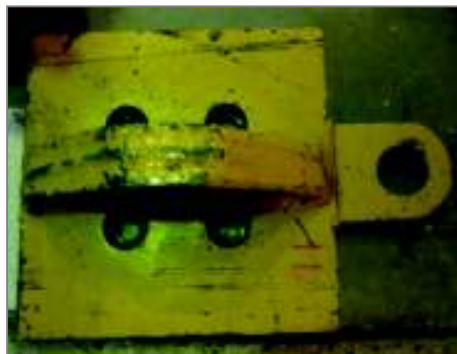
FOTOGRAFÍA 4.13 PLACA DE UNIÓN MURO RÓTULA.
