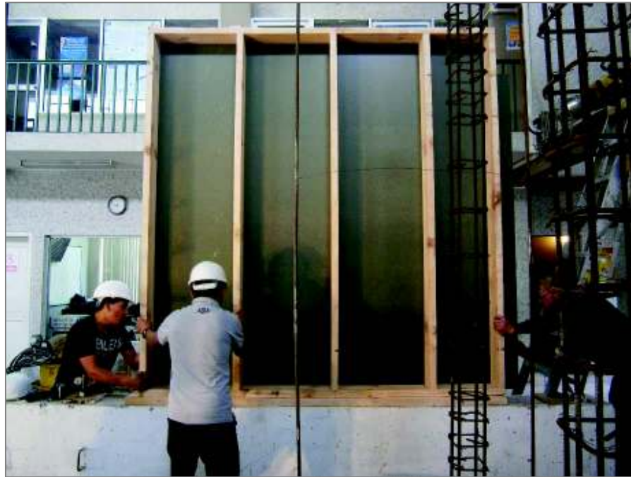
FOTOGRAFÍA 4.24 MONTAJE DEL MURO SOBRE VIGA DE CIMENTACIÓN.
