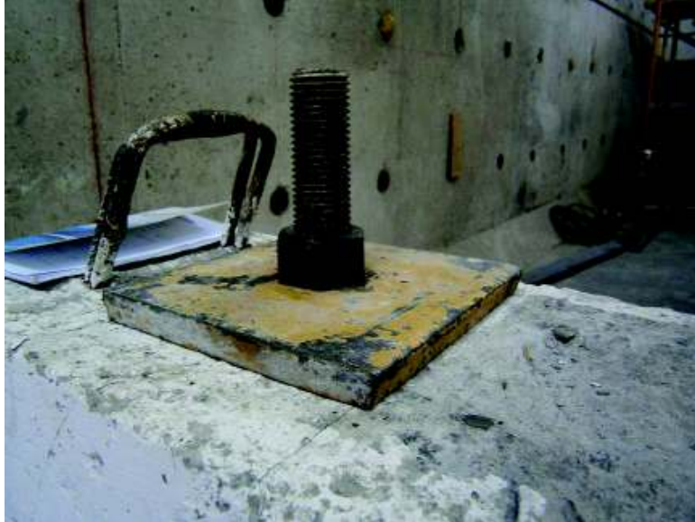
FOTOGRAFÍA 4.27 VIGA DE CIMENTACIÓN PRETENSADA.
