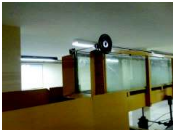
Figura 3. 7: Compuerta de descarga del canal
