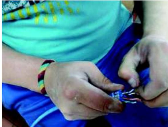
**Figura 16. Paso de los pares a través del Jack**
