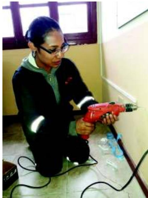
Figura 13. Instalación de canaleta para la bajante
