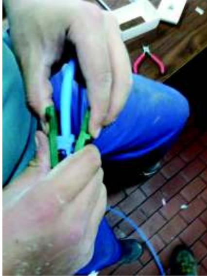
**Figura 18. Aseguramiento del cable al Jack**
