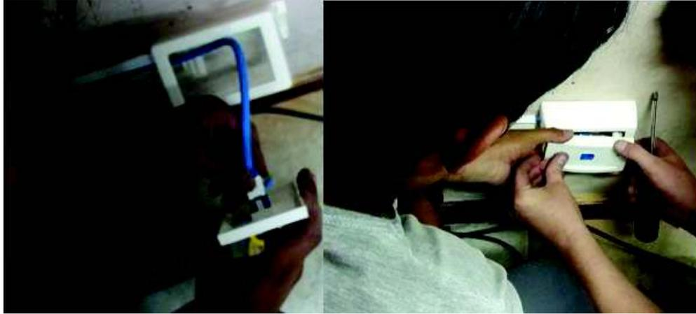
Figura 20. Colocación del Jack en el faceplate y cierre de la caja sobre puesta
