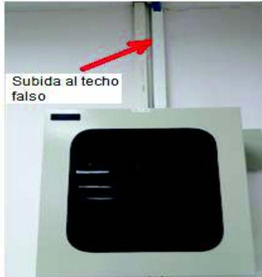
Figura 12. Instalación de canaleta de subida al techo falso
