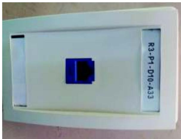
Figura 5. Etiqueta del punto de red instalado en cada aula
