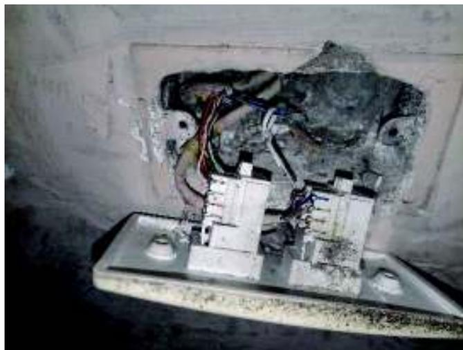
Figura 1. Cableado deteriorado aulas ESFOT
