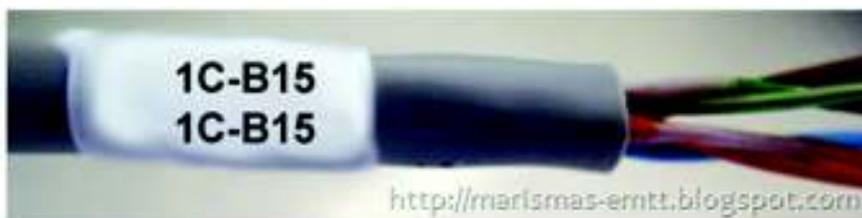
Figura 20. Forma de etiquetado según el estándar ANSI/TIA/EIA-606A (del Río Ruíz, 2017)
