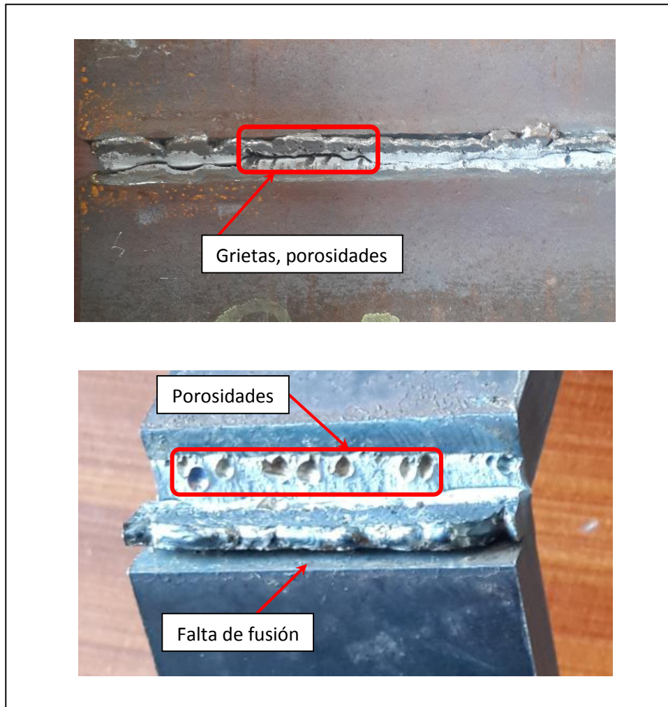
Figura 2. 23. Defectos de soldadura en la fabricación de monopolos. (Fuente: Imágenes en probetas de Instrumental INC.)
