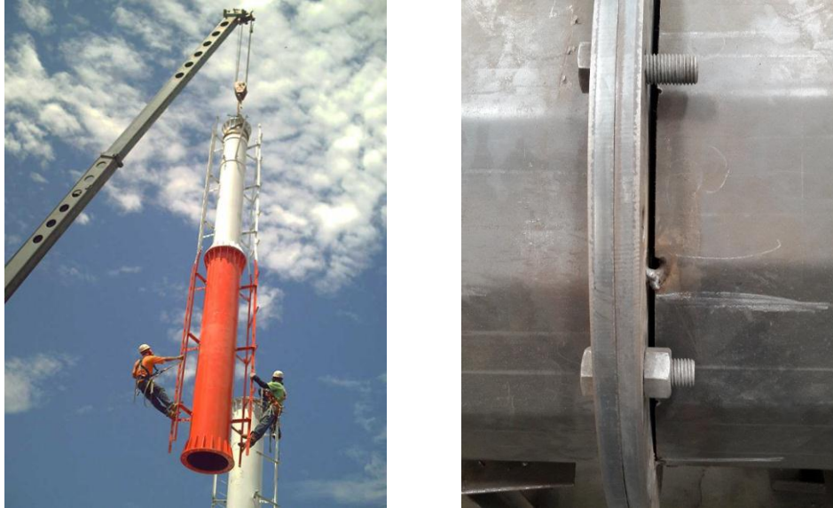
Figura 2. 21. Montaje de la estructura para monopolos (Fuente: Imágenes de Instrumental INC.)
