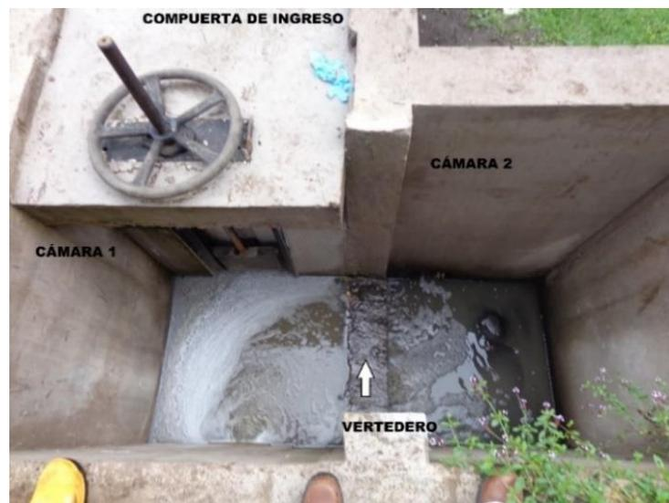
**FIGURA 3.1 SEPARADOR DE CAUDALES Y COMPUERTA DE INGRESO**
