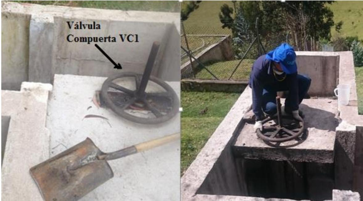
**FIGURA 4.1 VÁLVULA DE COMPUERTA VC-1**
