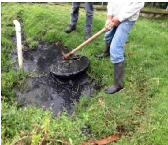
**FIGURA 3.23 ESCURRIMIENTO DEL AGUA RESIDUAL EN EL TERRENO**
