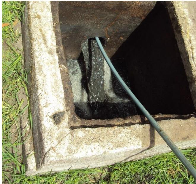
**FIGURA 3.16 DESTAPONAMIENTO DE UNA CAJA DE REVISIÓN**
