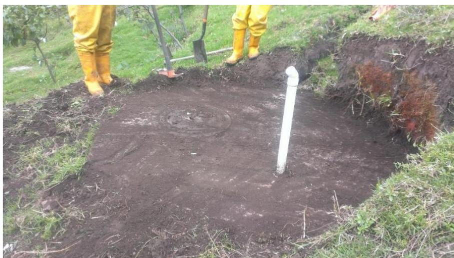
**FIGURA 3.26 LIMPIEZA DE LA TAPA DE INSPECCIÓN DEL POZO DE INFILTRACIÓN**
