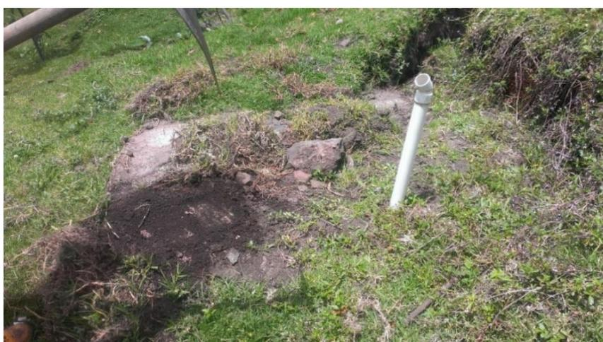
**FIGURA 3.25 MALEZA EN LA TAPA DEL POZO DE INFILTRACIÓN**
