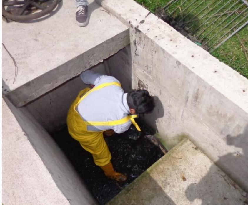
**FIGURA 4.3 LIMPIEZA DEL CANAL DE CRIBA**
