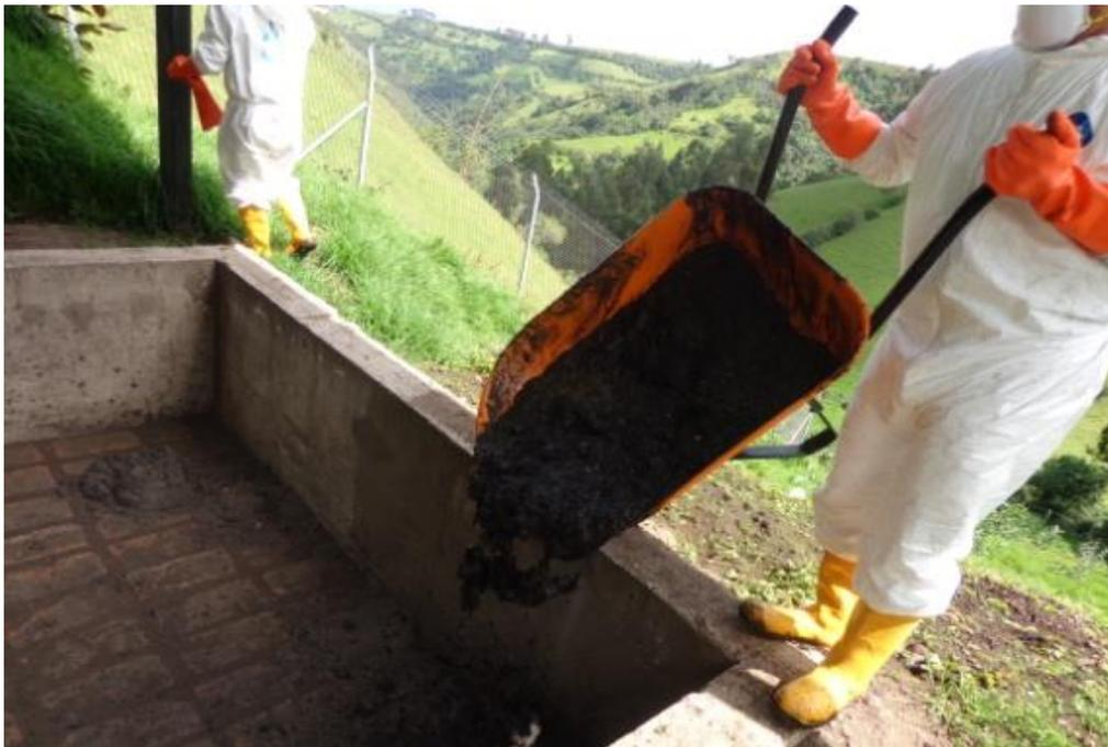
**FIGURA 4.12 DISPOSICIÓN DE LODOS PRIMARIOS**
