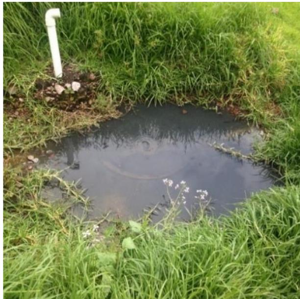
**FIGURA 3.22 SATURACIÓN DE UN POZO DE INFILTRACIÓN**
