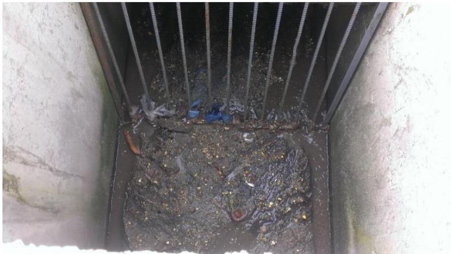
**FIGURA 3.19 TAPONAMIENTO DEL CRIBADO**
