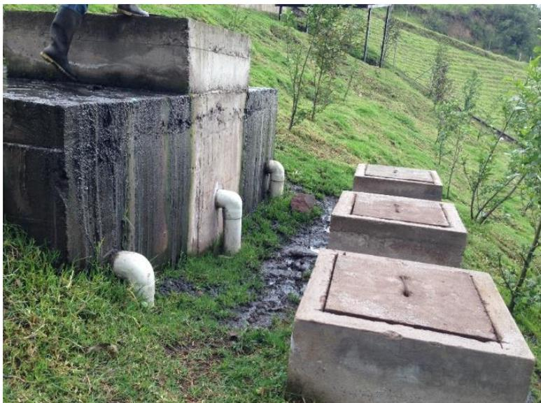
**FIGURA 3.5 CAJAS DE DISTRIBUCIÓN HACIA LOS POZOS DE INFILTRACIÓN**
