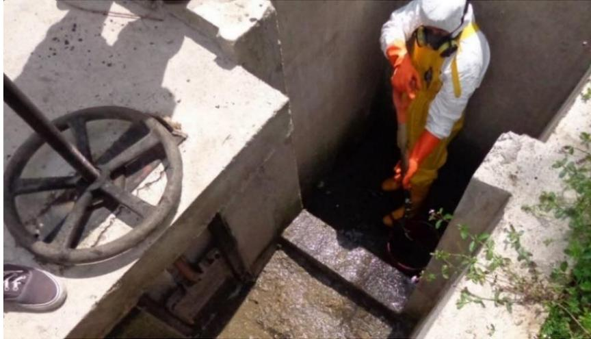
**FIGURA 4.4 LIMPIEZA DEL SEPARADOR DE CAUDALES**
