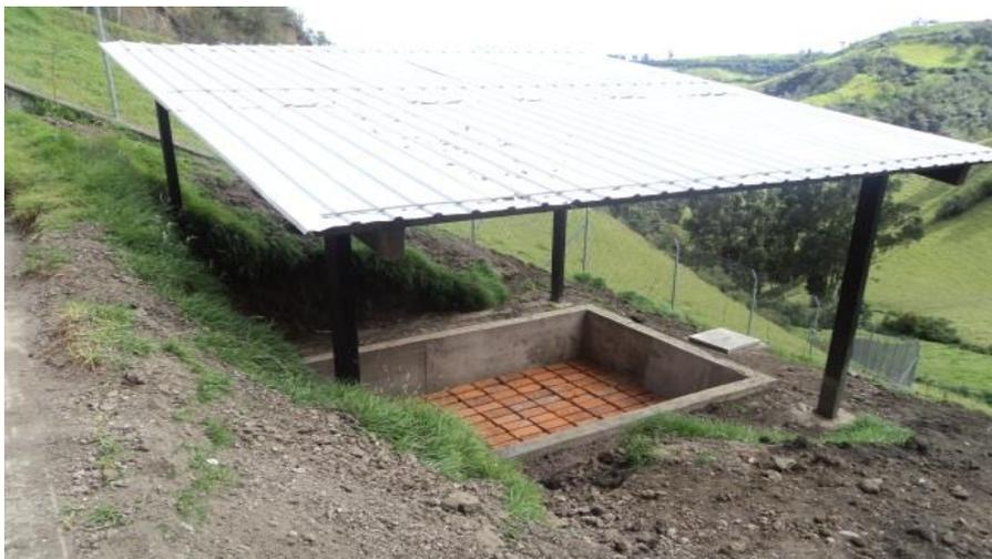
**FIGURA 3.10 LECHO DE SECADO DE LODOS**
