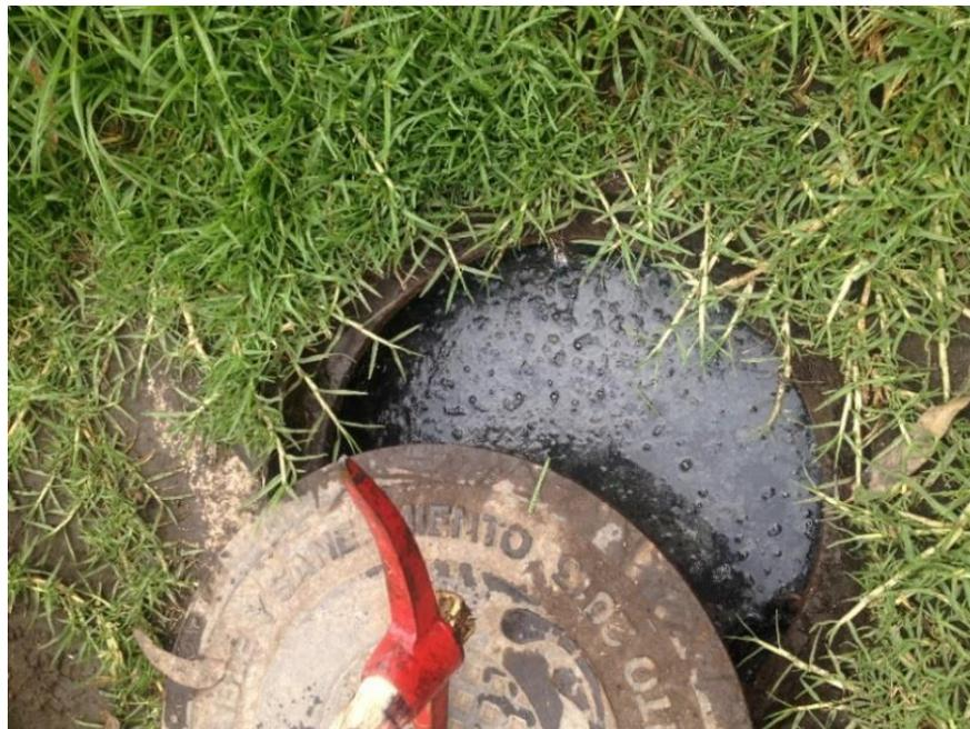
**FIGURA 3.7 POZOS DE INFILTRACIÓN**
