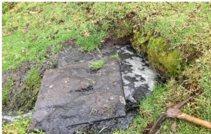
**FIGURA 3.15 OBSTRUCCIÓN DE UNA CÁMARA DE REVISIÓN**
