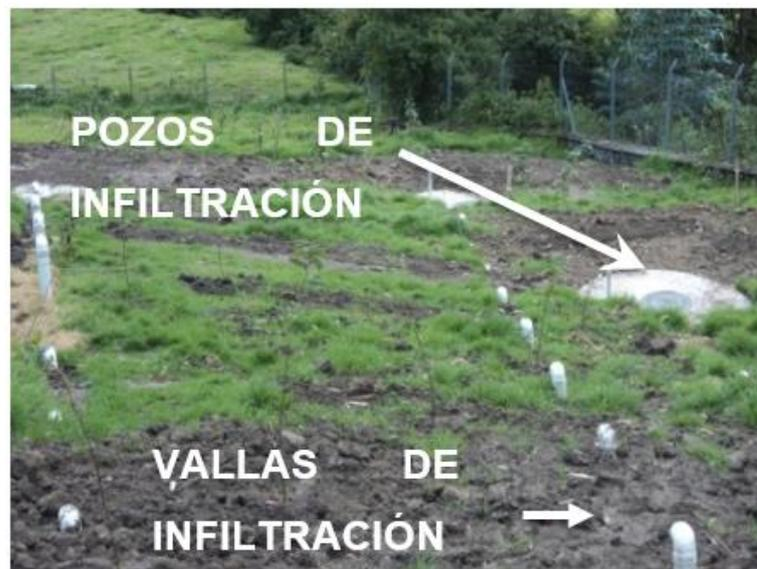
**FIGURA 3.9 VALLAS Y POZOS DE INFILTRACIÓN**
