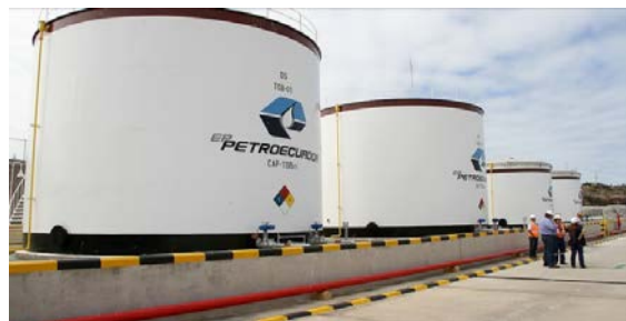
Figura 25 – Tanques de Almacenamiento (Ecuadorianoenvivo, 2015)
