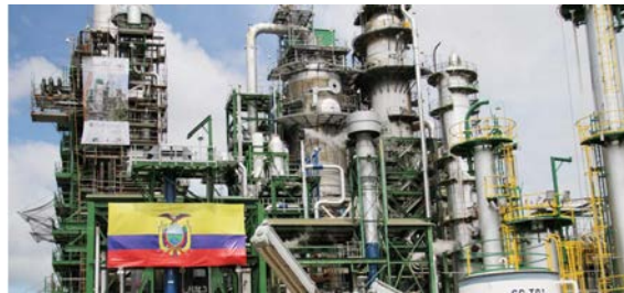
Figura 22 – Refinería Estatal de Esmeraldas (El Telegrafo, 2016)
