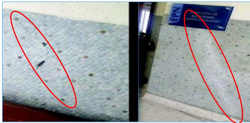
**FIGURA 3. 82** FOTOGRAFÍA DE FISURAS EN LOSAS.
