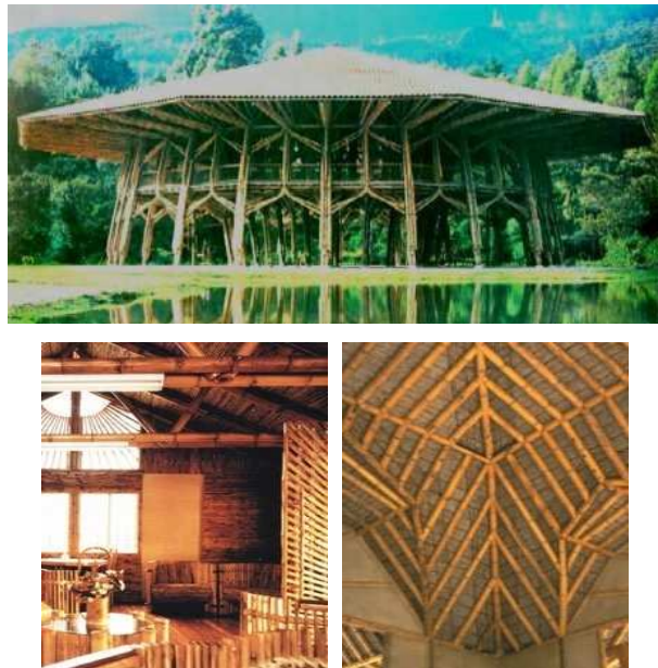
Figura 1.6: Construcciones con caña guadua
