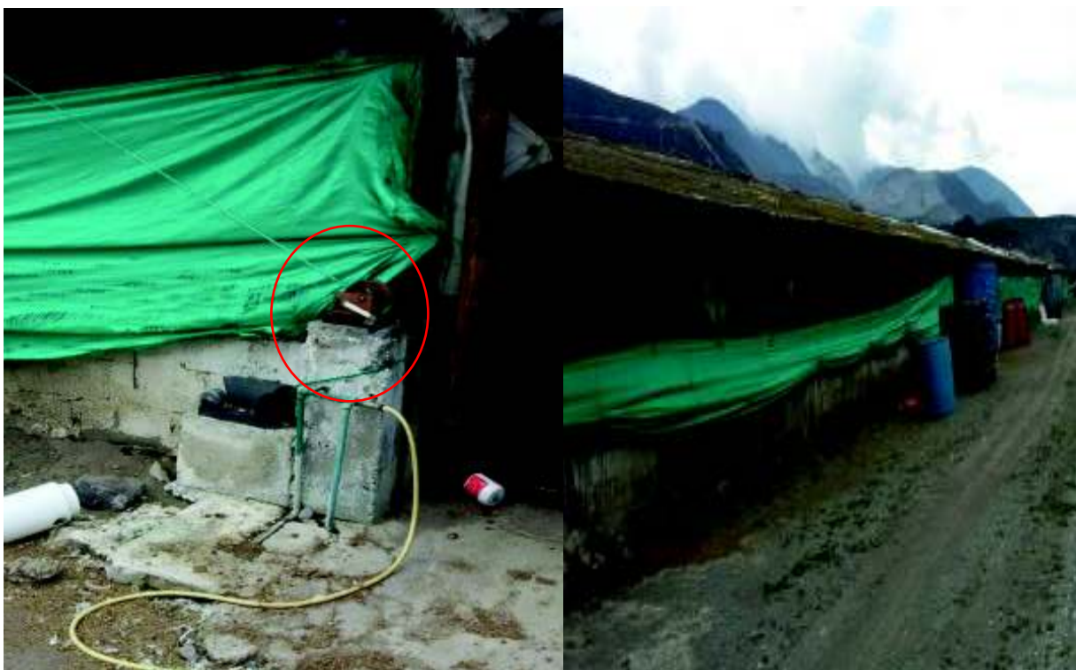
Figura 25. Sistema de apertura manual de ventilación Fuente: Propia
