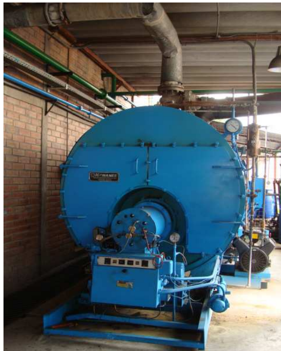
Figura 2.17.- Caldero pirotubular
