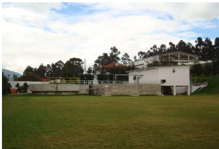
Figura 1.3.- Planta de tratamiento de aguas residuales
