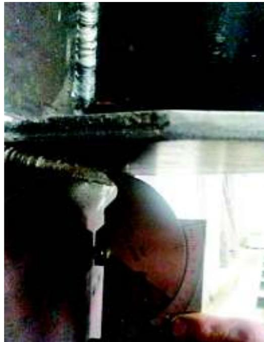
**Figura 2-32.-** Medición del filete colocado el patín inferior de la viga
