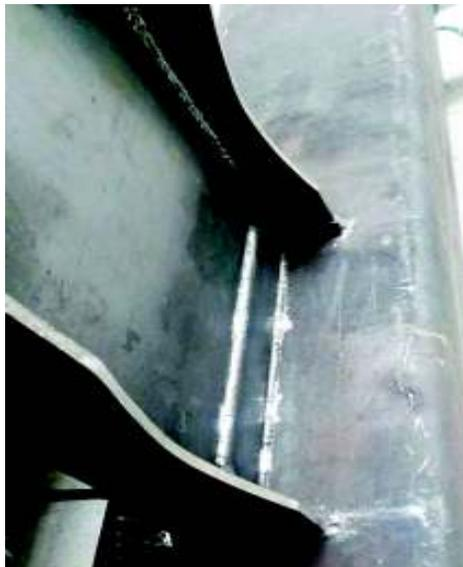
**Figura 2-34.-** Vista frontal conexión viga de sección reducida-columna con diagonales internas
