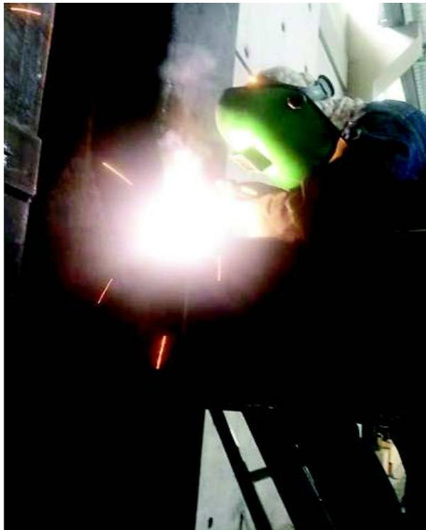
**Figura 2-30.-** Soldadura proceso SMAW. Posición 1G entre la columna y el patín superior de la viga
