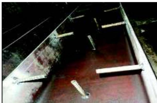
**Figura 2-14.-** Varillas Ø14 mm para obtener anclaje mecánico entre la columna de acero y el relleno de hormigón
