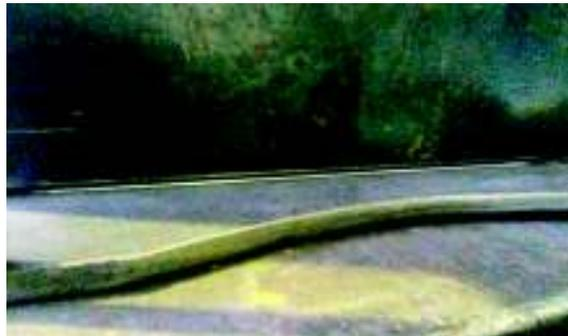
**Figura 2-25.-** Angulo de canal entre el alma de la viga y el patín inferior de la misma, en la zona protegida.
