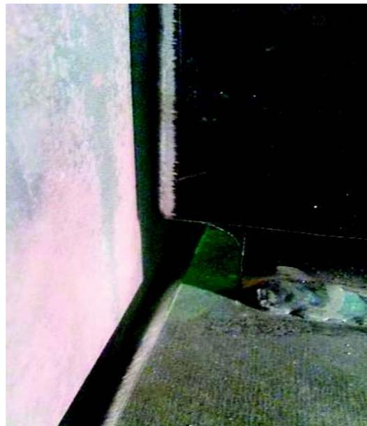
**Figura 2-28.-** Ángulo de canal del alma de la viga y el patín inferior
