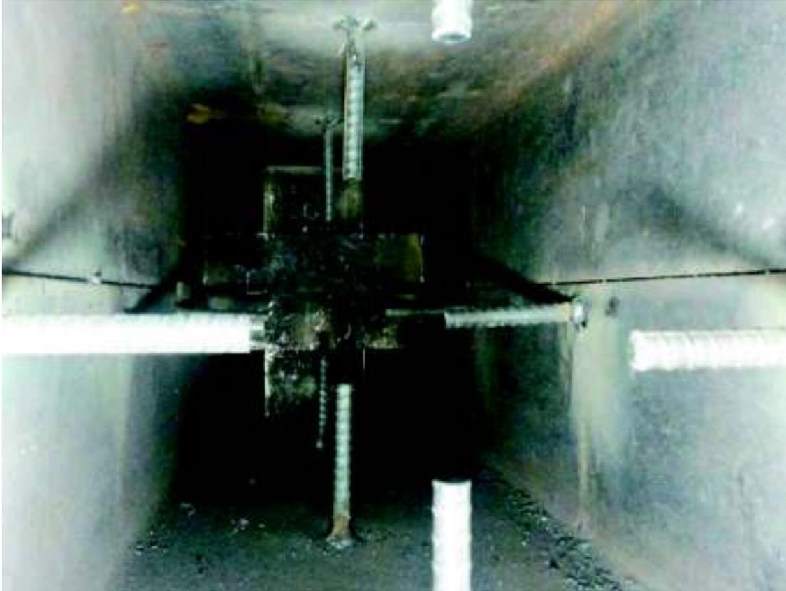
**Figura 3-104.-** Placas de Continuidad dentro de columna RCFT en Probeta 5 cortesía (Ing. Hugo Pillajo)
