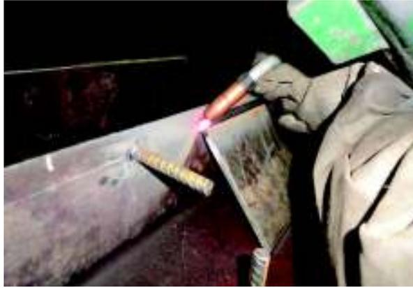
**Figura 2-18.-** Proceso de soldadura FCAW, posición 1G entre diagonal interna y el canal U350x175x8mm en columnas para probetas del modelo 1 y modelo 4
