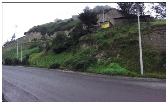
**Fotografía 5.20** Vía Panamericana, excavación y carga hacia la corona del deslizamiento principal.
