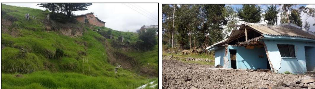
**Fotografía 5.1** Efecto de los coluviales. Reptación y daños a infraestructura. Tunaspamba 1 (izquierda) y Tambo, sector de Picopalta (derecha).
