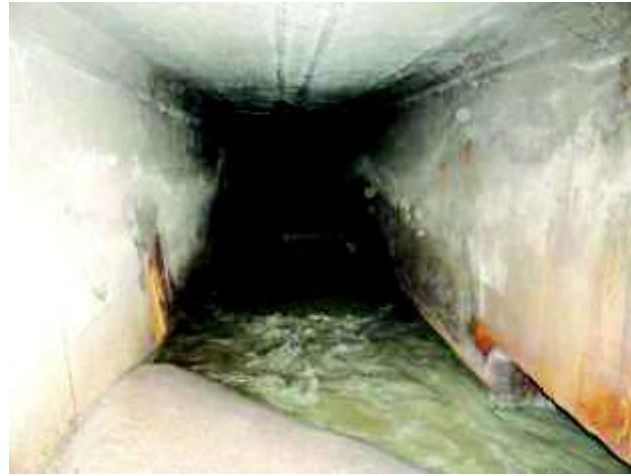
Fotografía 2-1: Estado actual del colector combinado
