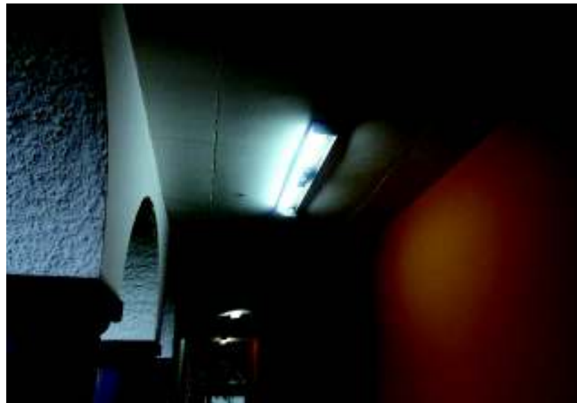
Figura 42 Comprobación de encendido de luminarias con tubos tipo Led. Fuente: (Pulla, 2016)
