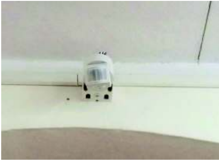
Figura 35 Instalación de sensor de movimiento en la pared (Pulla, 2016)
