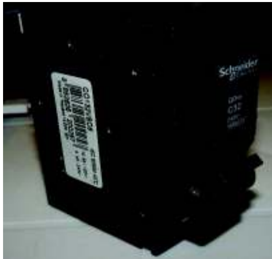
Figura 20 Breaker enchufable en tablero con barras de conexión Fuente: (Pulla, 2016)
