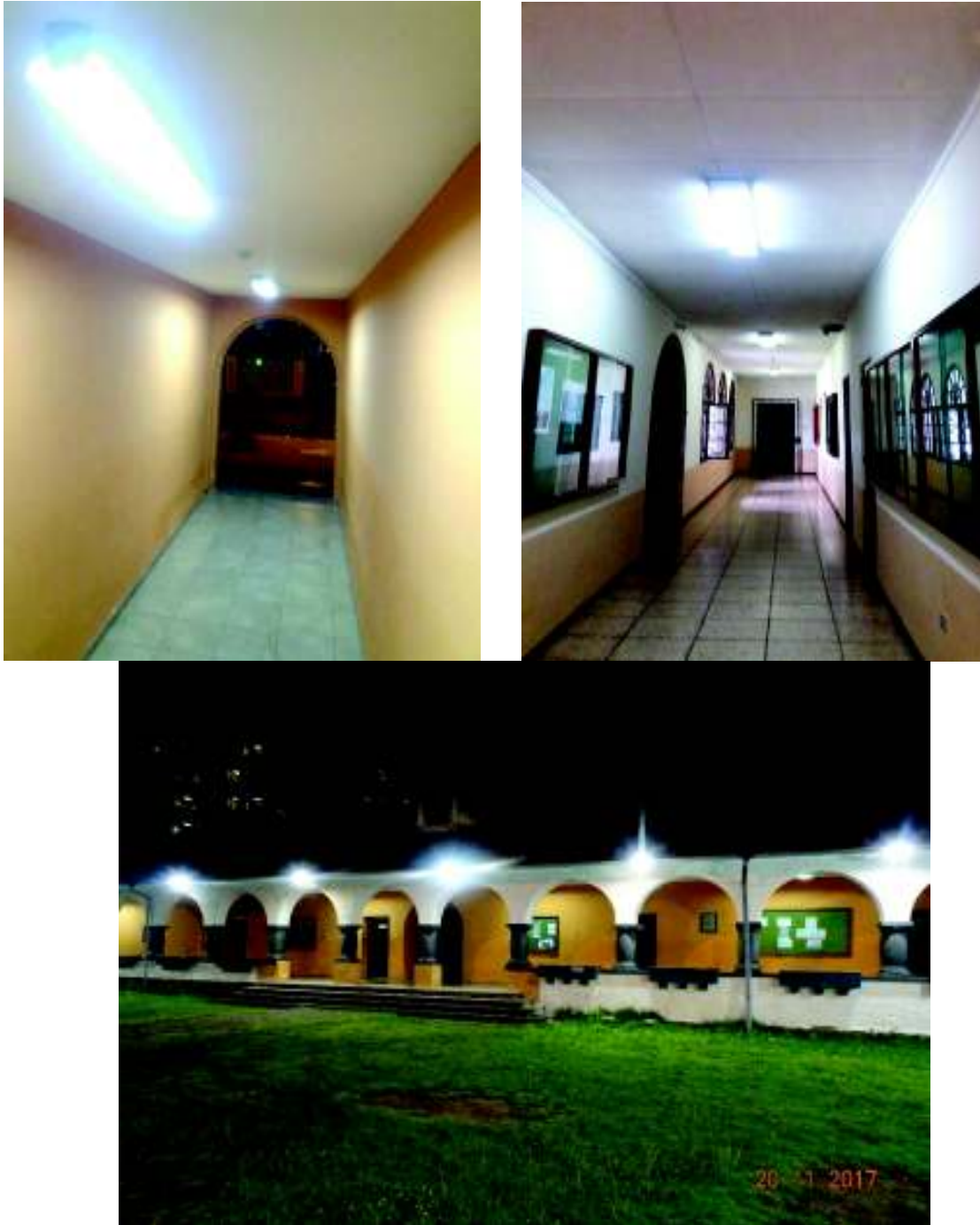
Figura 46 Encendido de luminarias con el nuevo sistema instalado. Fuente: (Pulla, 2016)
