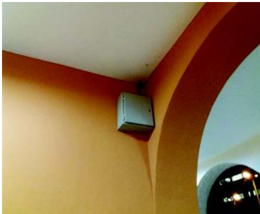
Figura 18 Instalación del tablero de control de iluminación Fuente: (Pulla, 2016)
