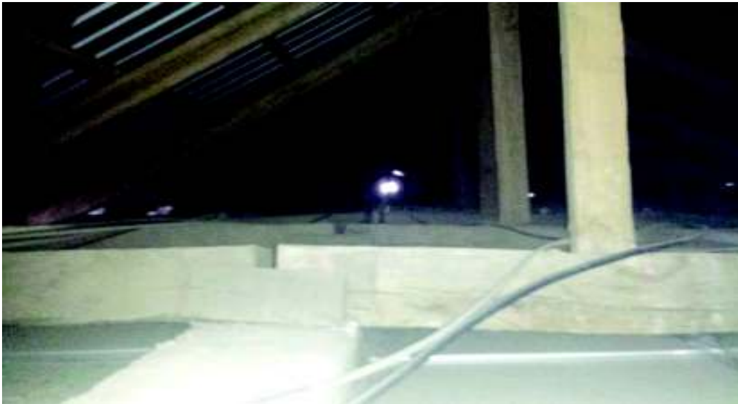
Figura 10 Acceso a las instalaciones de la ESFOT Fuente: (Pulla, 2016)
