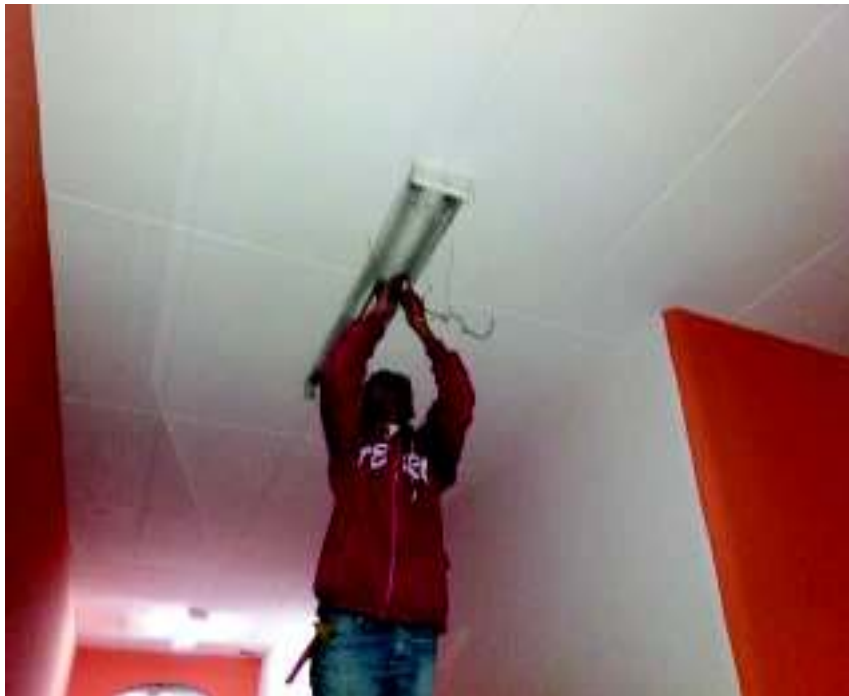
Figura 41 Reemplazo de lámparas de tubo fluorescentes por lámparas de tubo tipo Led. Fuente: (Pulla, 2016)
