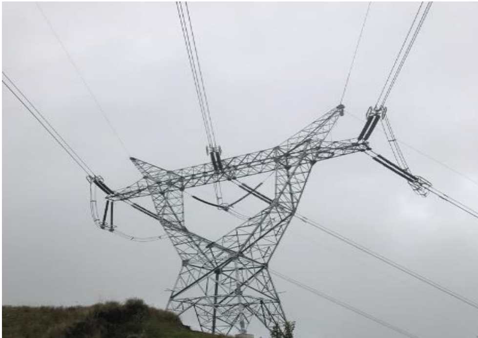
Figura 3.10. Torre de transmisión 323 de la L/T Inga-Tisaleo_500 kV [28].
