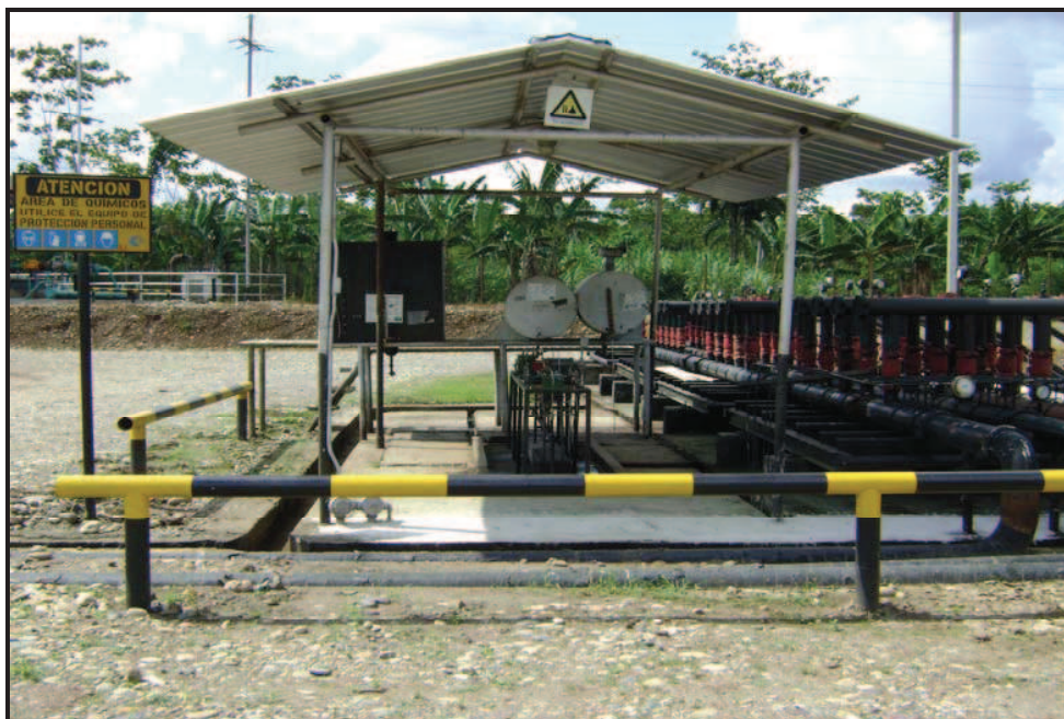
FOTO N° 1.22: INYECCIÓN DE QUÍMICOS TANQUE DE LAVADO
