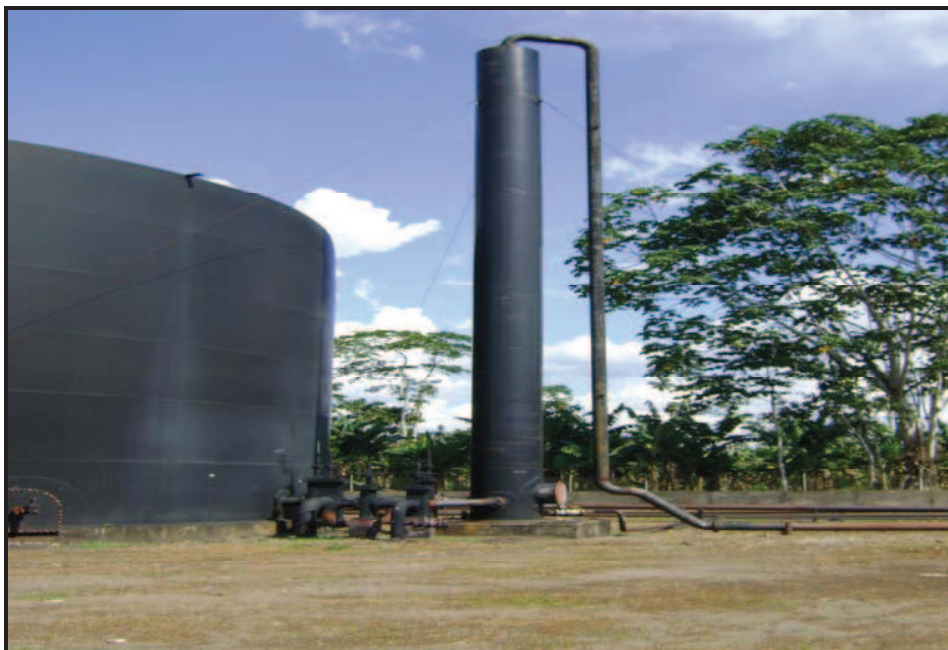
FOTO N°1.4: BOTA DESGASIFICADORA
