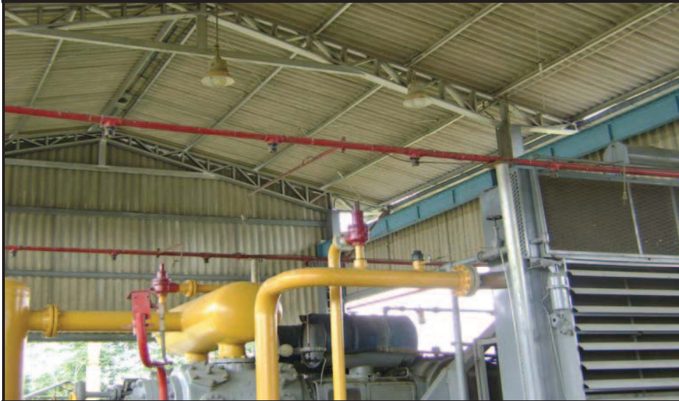
FOTO N° 1.17: SCI DEL SISTEMA DE COMPRESIÓN
