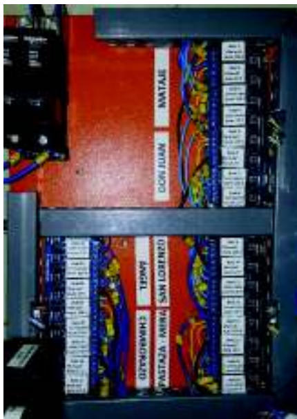
Figura 2.12 Distribución de relés por diorama a iluminar
