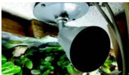
Figura 4.8 Soporte para lámpara ubicado en el techo del diorama
