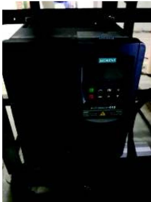
**Figura 48** Variador de Frecuencia Siemens Master 440
