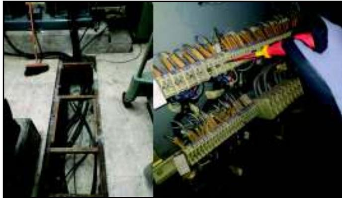
**Figura 81.** Labores de Limpieza y Ajuste en Canales y Tablero Principal
