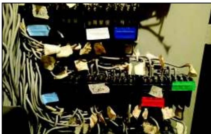
**Figura 61.** Señalización de Elementos de Control del Panel 5 - Tablero Siemens
