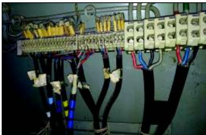
**Figura 60.** Señalización de Cables en Borneras - Panel 5 del Tablero Siemens
