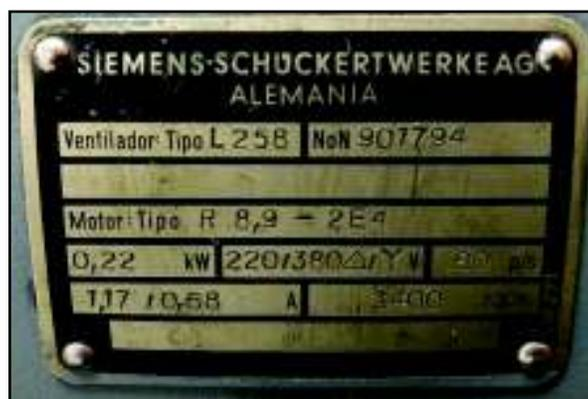
**Figura 74.** Datos de Placa de los Ventiladores del Conjunto Motor DC – Generador AC
