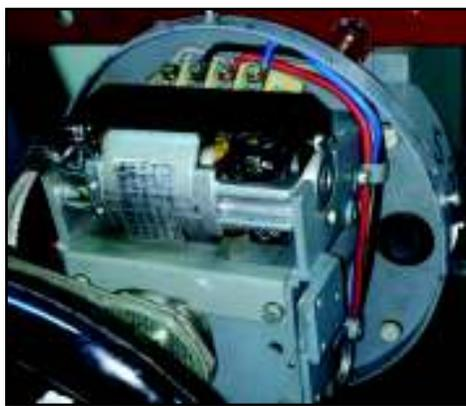
**Figura 79.** Motor Monofásico de Fase Partida Instalado en el Cuarto de Máquinas.
