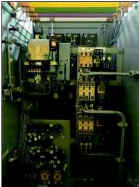
**Figura 59.** Instrumentación de Control del Equipamiento Ward Leonard
