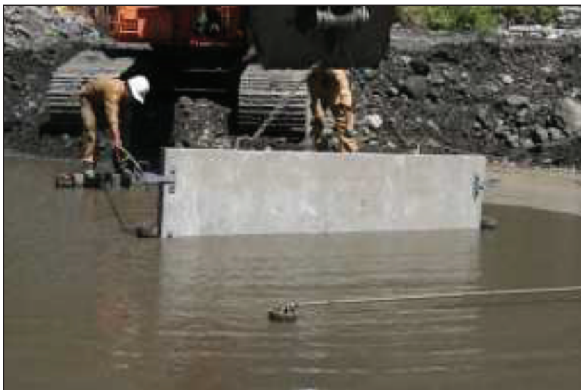
FIGURA 1.7 INSTALACIÓN DE PANELES SUMERGIDOS EN EL RÍO CÁQUEZA, COLOMBIA.
