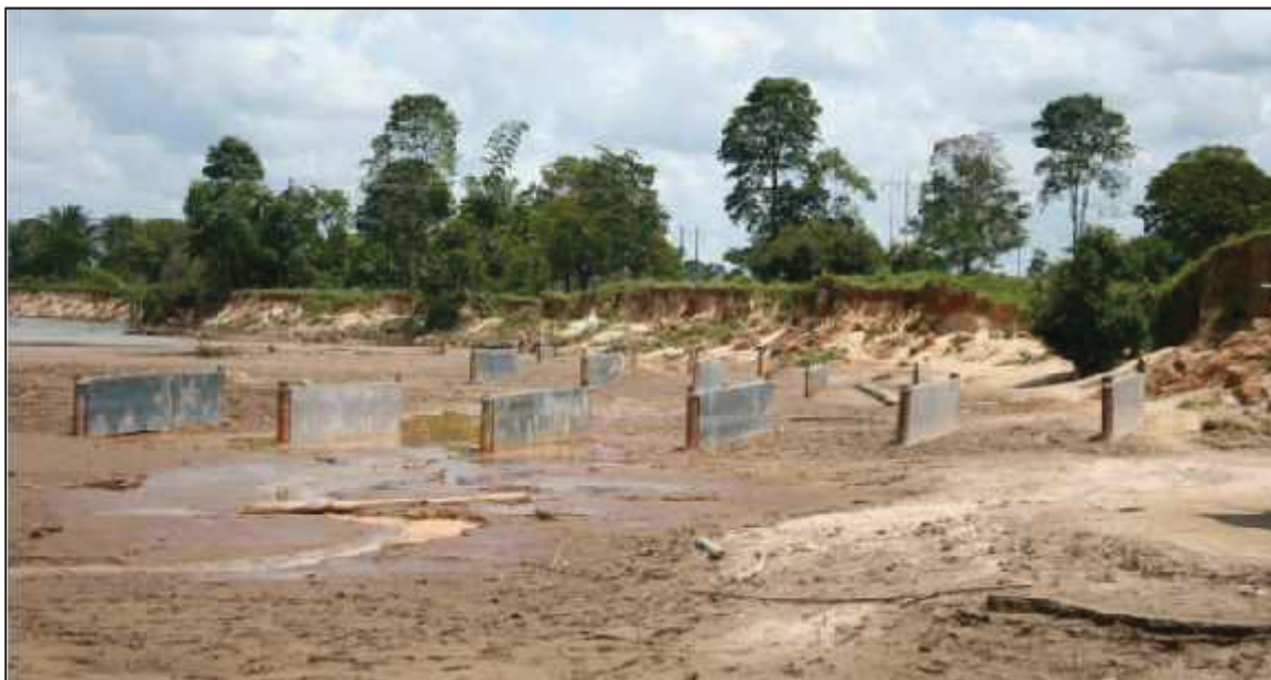
FIGURA 1.5 PANELES DURANTE SU IMPLANTACIÓN EN EL CAUCE DEL RÍO BANADIA, COLOMBIA.
