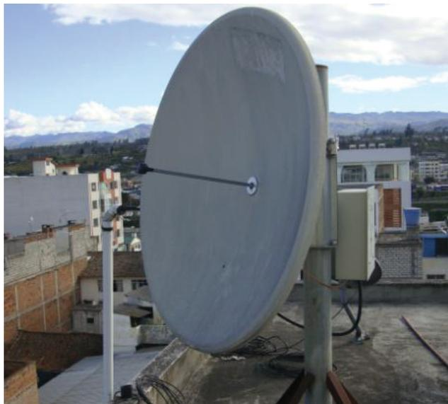
Figura 3.29 Antena parabólica de 1.2m
