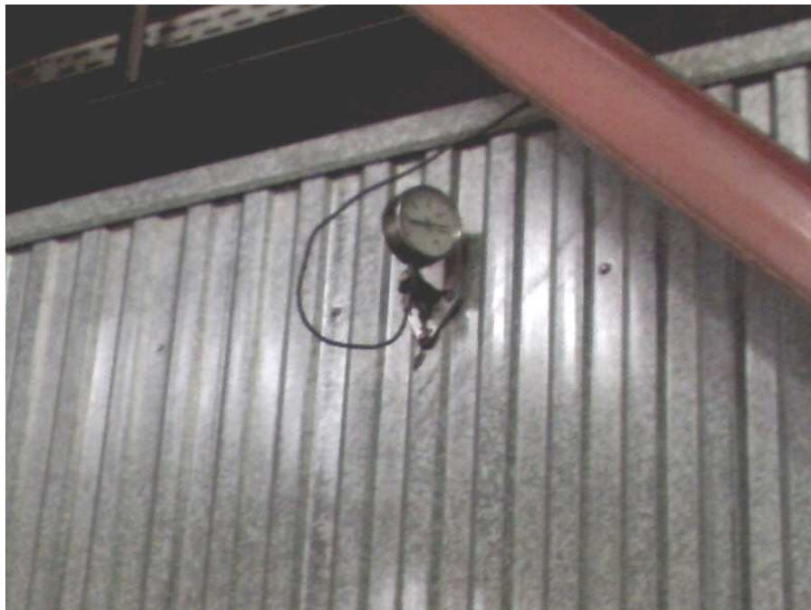
Figura 2.1 Termocupla y Visualizador Análogo Locales
