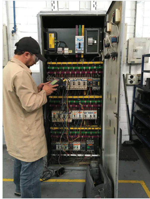
Preparación para mediciones en tablero del galpón
