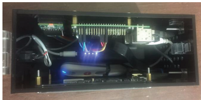
Figura 2.60 Disposición Interna de los equipos.
