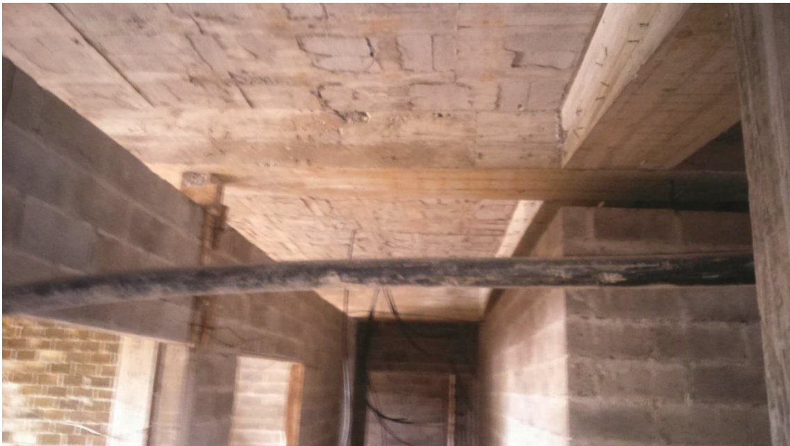
Altura de las paredes del edificio.
