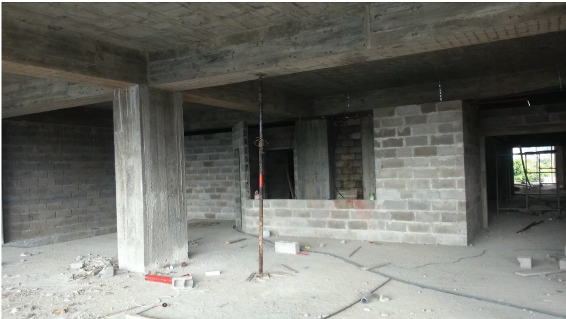
Parte frontal en el mezzanine del edificio.
