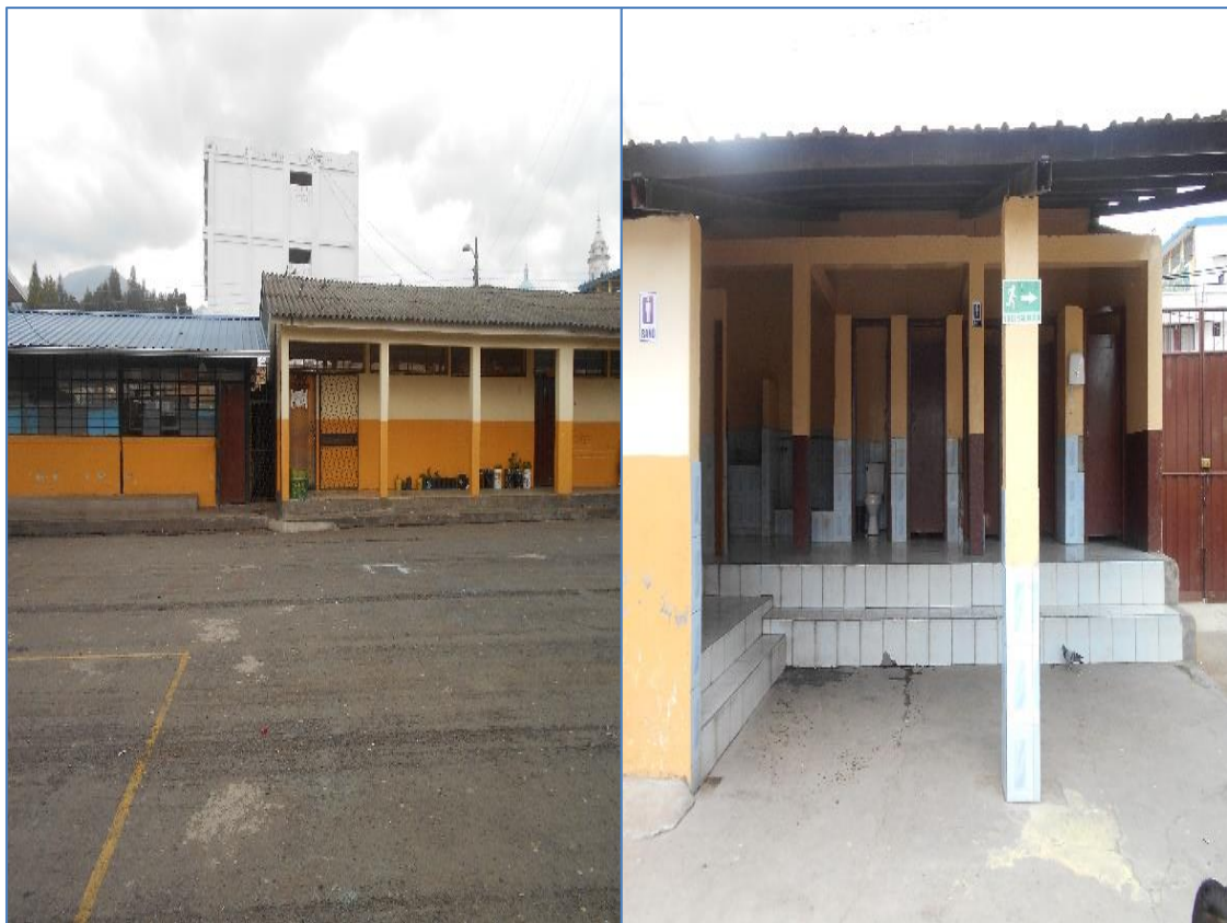
Figura 1.9 Bloque aulas prefabricadas.
