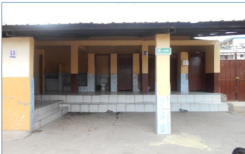
Figura 1.13 Baños de las aulas prefabricadas
