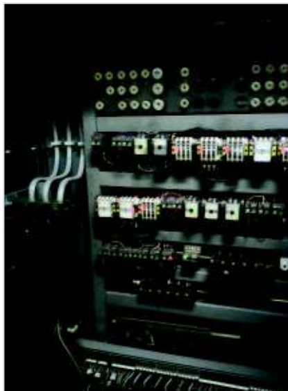
Figura 1.7. Tablero eléctrico 1 de fuerza del sistema de motores periféricos
