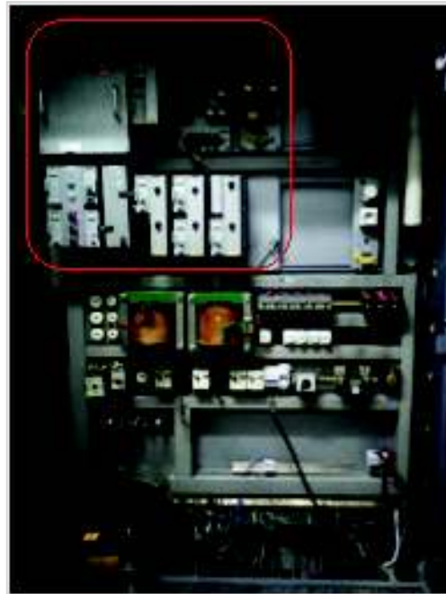
Figura 1.11. Ubicación del sistema conversor AC/DC
