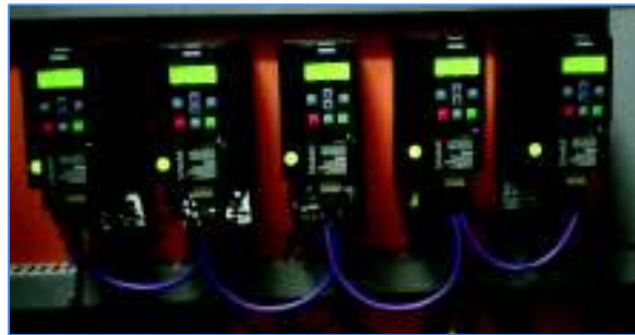
Figura 2.27. Cableado del bus de comunicación MODBUS-RTU
