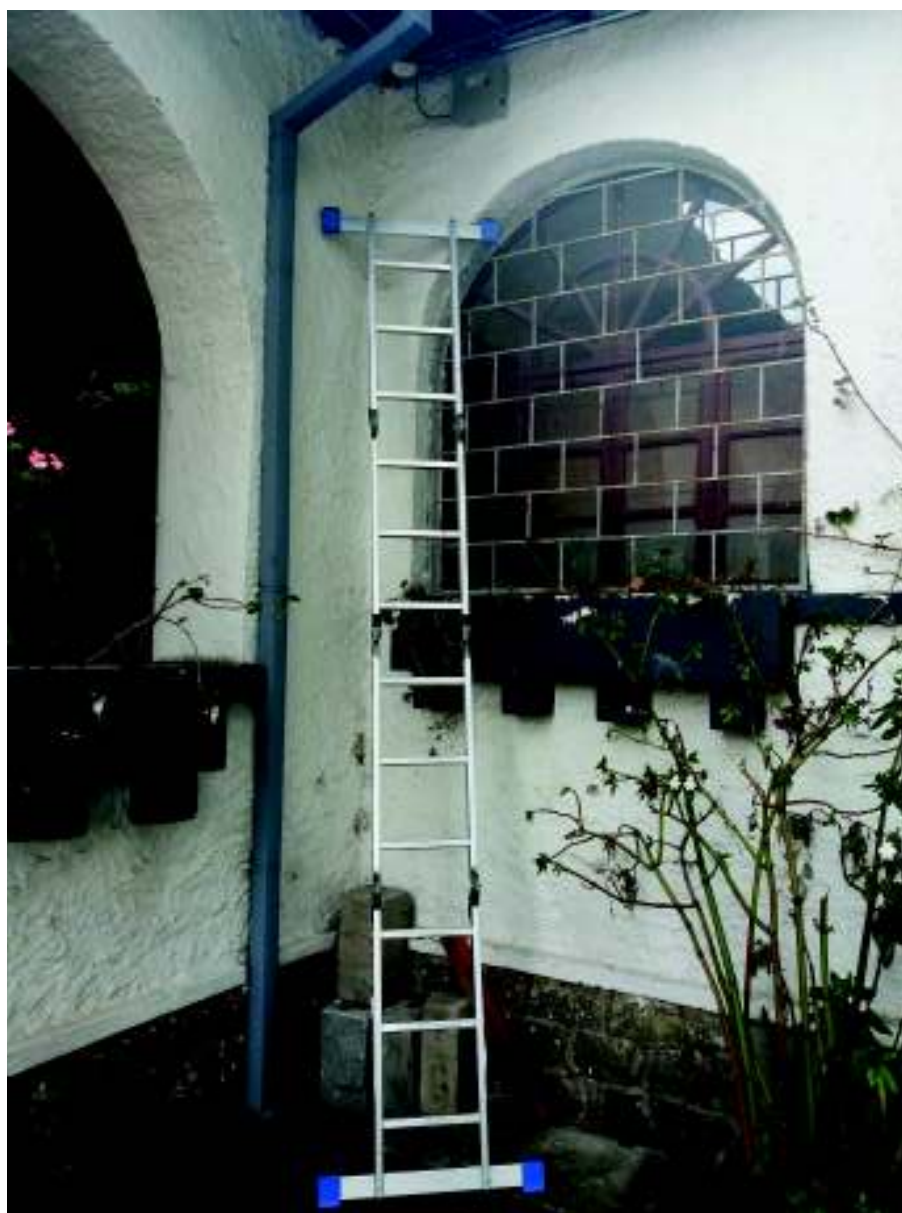
Figura 51: Instalación a altura
