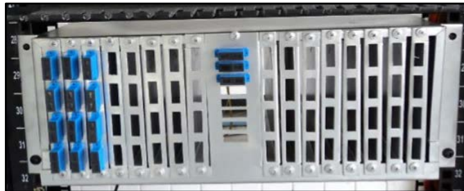
Figura 2.41 ODF de splitters de primer nivel [57]
