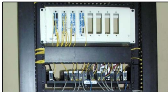
Figura 2.8 Bandeja de rack con Transceivers TP-Link [74]
