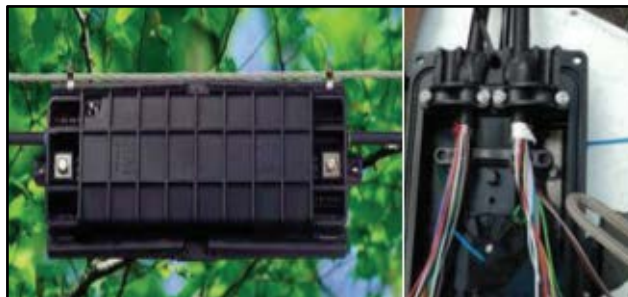
Figura 2.53 Manga de empalme tipo lineal para fibra óptica [103]
