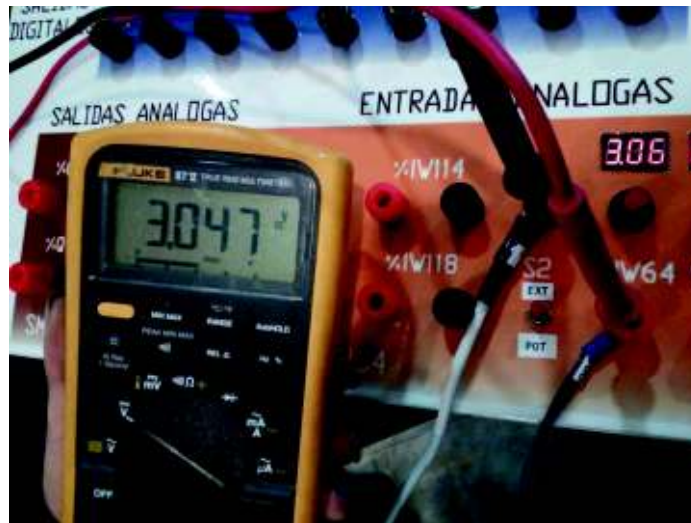
Figura 3.47 Funcionamiento de potenciómetros y voltímetros.
