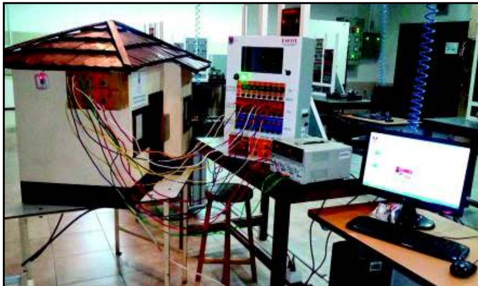
Figura 3.56 Sistema Domótico funcionando correctamente.
