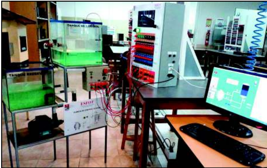
Figura 3.51 Sistema de Control de Nivel funcionando correctamente.
