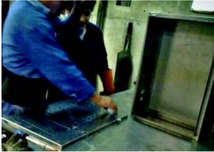
Figura 3.18 Construcción del gabinete eléctrico.
