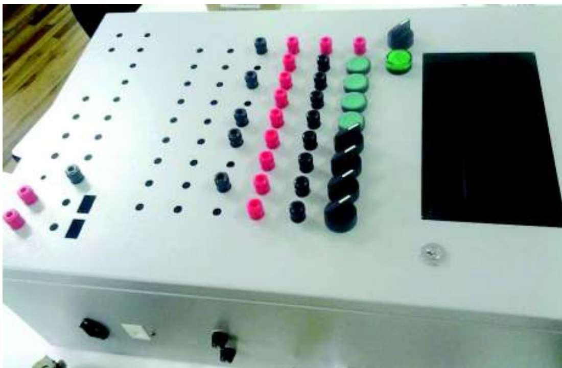
Figura 3.21 Montaje del gabinete.
