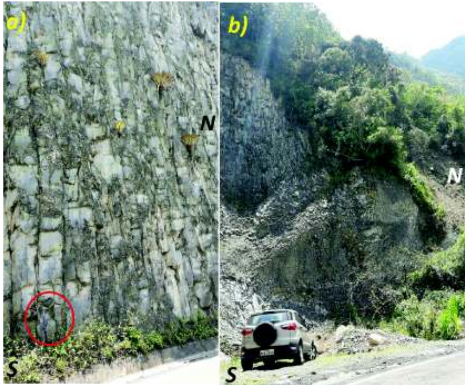
Figura 3.20. Tungurahua I. (a) Parte basal del flujo de lava andesítico, tomado en el punto [TI-04 UTM: 789_{150} / 9846_{901} ], se evidencia tres familias de diaclasas (b) Parte superior del flujo de aproximadamente 20 m. de alto levemente deformado (centro de la fotografía), tomado en el punto [TI-05 UTM: 788_{651} / 9847_{549} ].
