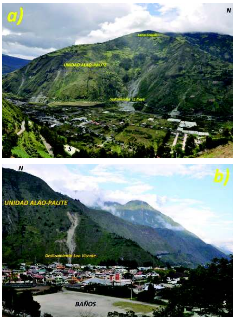
Figura 1.4. Deslizamientos en la zona de estudio.
