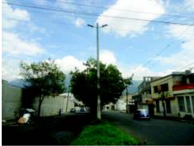
Figura 3.10. Avenida N52 De Los Algarrobos.
