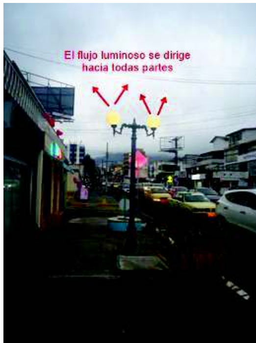
Figura 1.1. Luminaria sin control de emisión de flujo luminoso.
