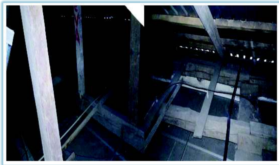
Figura 13 Edificaciones actuales ESFOT
