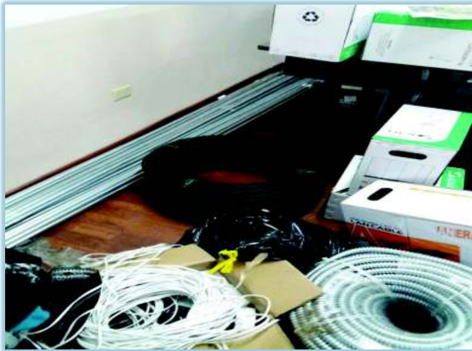
Figura 14 Material utilizado para cableado horizontal
