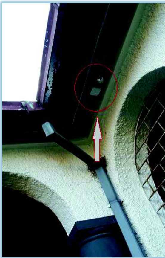
Figura 21 Cámara instalada plazoleta sur
