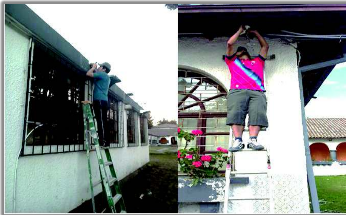
Figura 19 Proceso de instalación de cámaras de video
