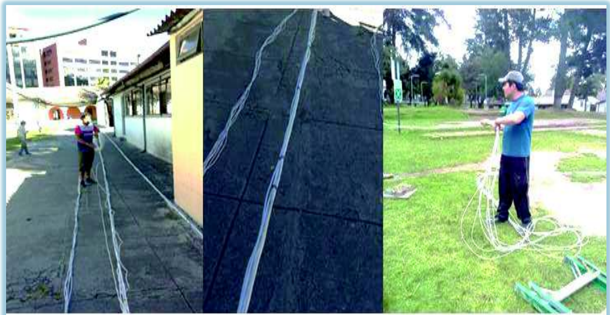
Figura 18 Tendido y canalización de cable
