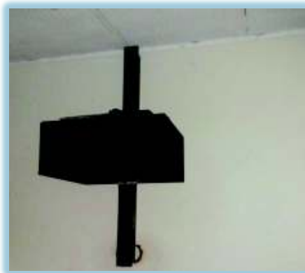
Figura 28 Montaje rack en pared
