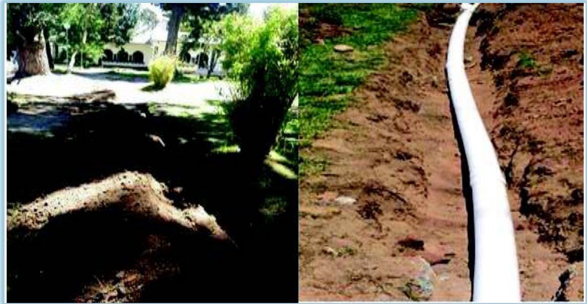
Figura 17 Obra civil, realización de canalización subterránea y tubería
