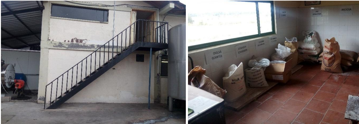
Figura 3. 4. Área de insumos en el segundo piso (Milma, 2017a)
