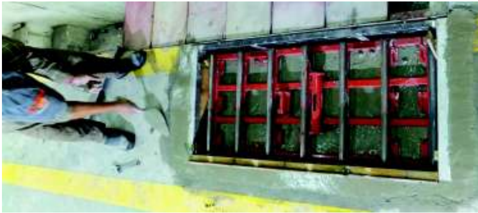
Figura 3.64. Relleno de concreto del: fondo y paredes laterales de la fosa Fuente: Propia
