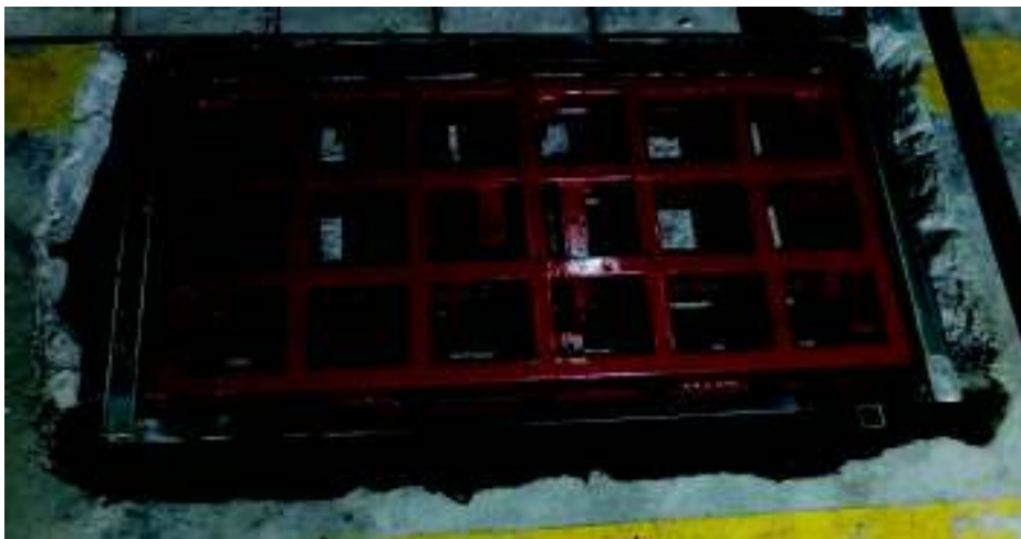
Figura 3.61. Anclaje del marco exterior a la estructura del equipo, con 8 pernos M10X 50mm de longitud
