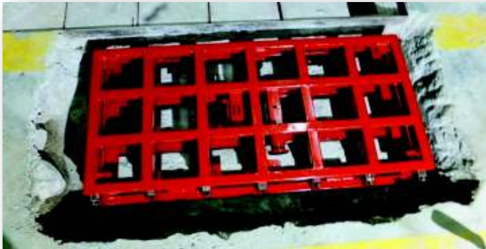
Figura 3.59. Anclaje de la estructura del equipo, en fosa de 120cm X 75cm X 16cm Fuente: Propia
