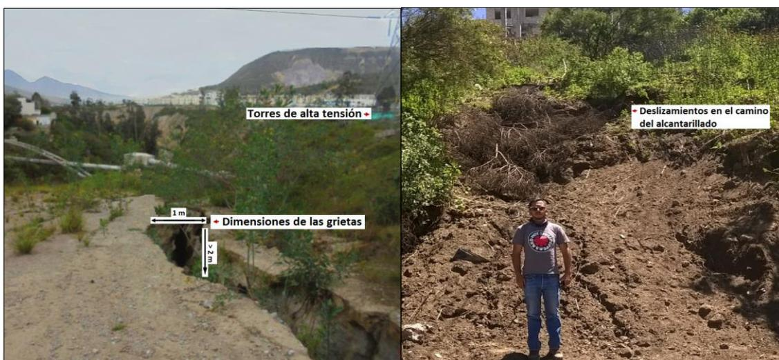
**Fotografía 1.1** Agrietamiento en superficie y deslizamientos a lo largo del camino del alcantarillado.
