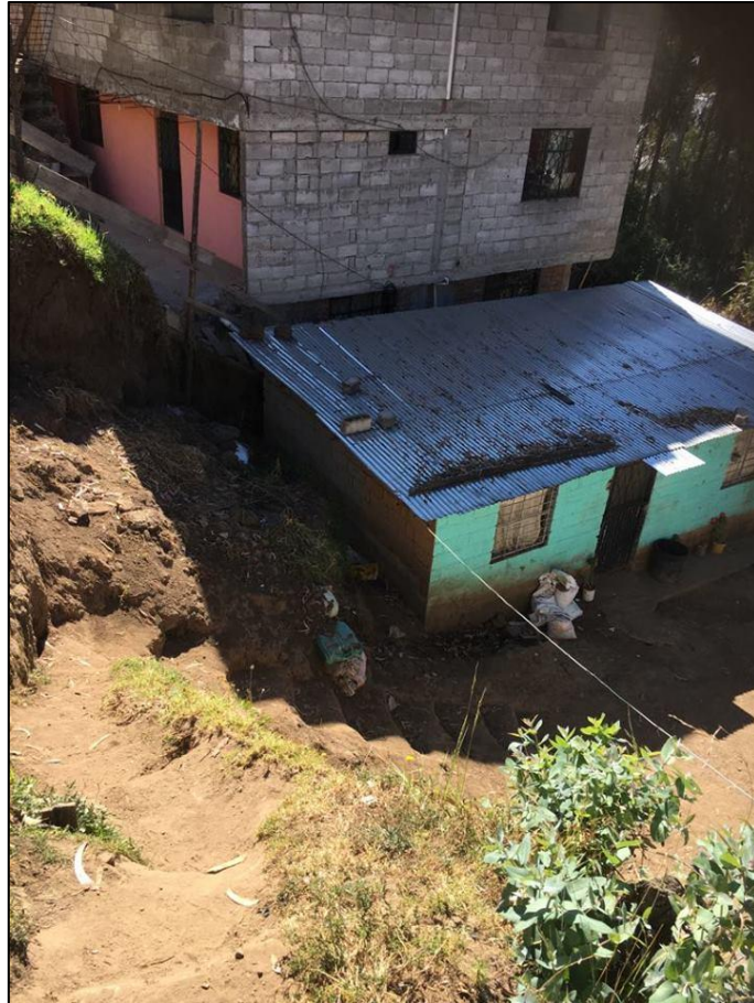
Fotografía 1.2 Casas ubicadas frente a taludes con pendientes fuertes
